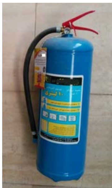
شکل ۱۱- کپسول آتش‌نشانی حاوی مخلوط آب و گاز
