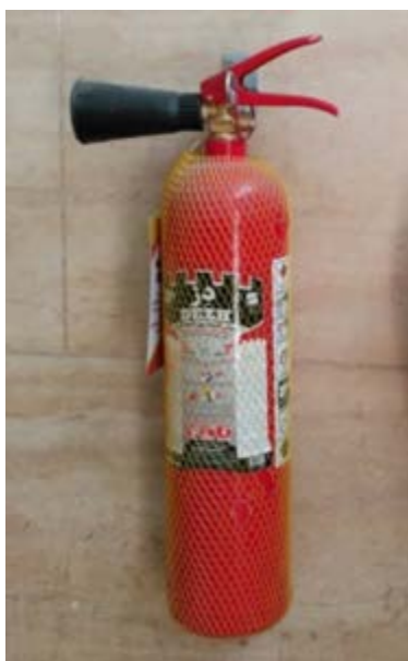
شکل ۱۲- کپسول آتش‌نشانی حاوی خاموش‌کننده دی‌اکسید کربن
