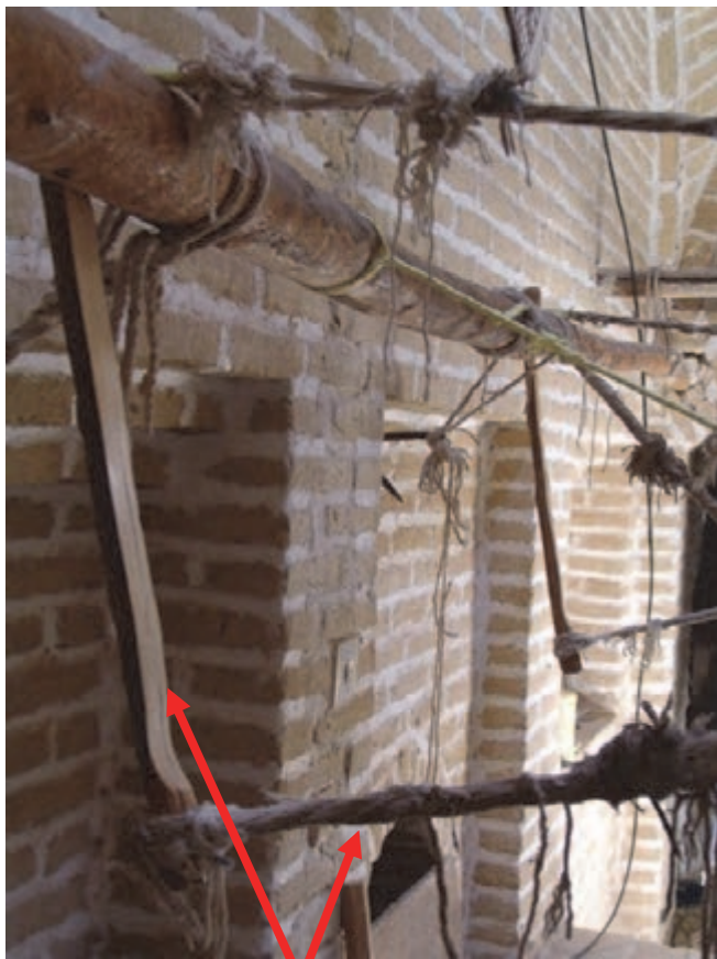
شکل ۳۶- کمونه و نخ اتصال آن
