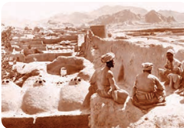
شکل ۵-۴- حصار و قسمتی از شهر قدیمی کرمان در عصر قاجار
