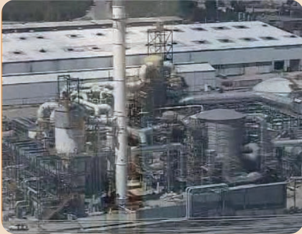
شکل ۶۲-۱- کارخانه اسیدسولفوریک سرچشمه
