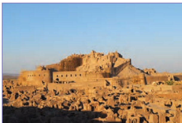
شکل ۳۱-۵- ارگ بم در حال بازسازی
