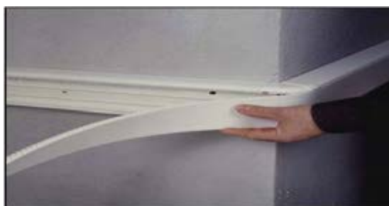
شکل ۴۴- نصب درپوش ترانکینگ زاویه دار
