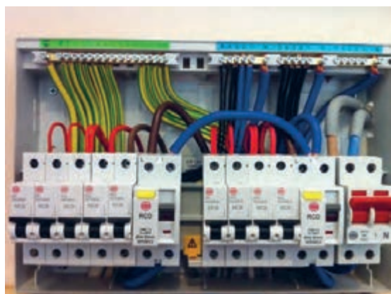
شکل ۴۹- اتمام سیم کشی قطعات تابلو
