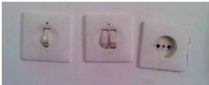
شکل ۱- نصب غلط کلید و پریز
