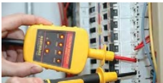
شکل ۵۴- تست تابلو با نشانگر ولتاژ
