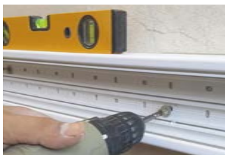
شکل ۴۹- نصب ترانکینگ
