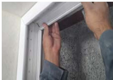
شکل ۵۰- برش و فارسی بر کردن ترانکینگ
