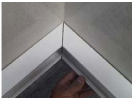
شکل ۵۰- برش و فارسی بر کردن ترانکینگ
