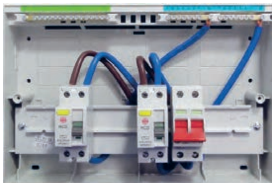
شکل ۴۷- سیم کشی قطعات تابلو
