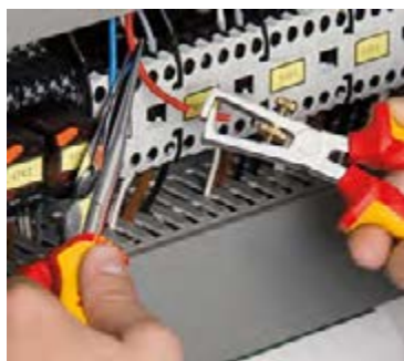
شکل ۹- روکش برداری با سیم لخت کن دستی
