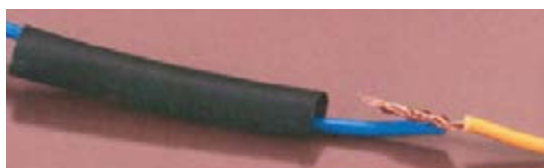
شکل ۲۲- عایق کاری اتصال
