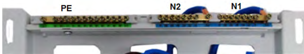
شکل ۸۰- ترمینال‌های نول و اتصال زمین
