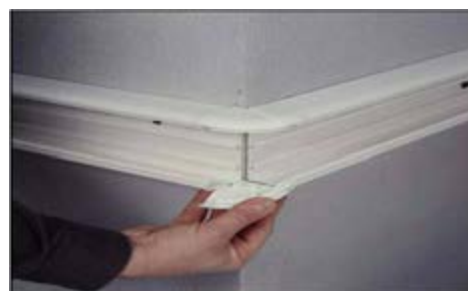
شکل ۴۴- نصب درپوش ترانکینگ زاویه دار
