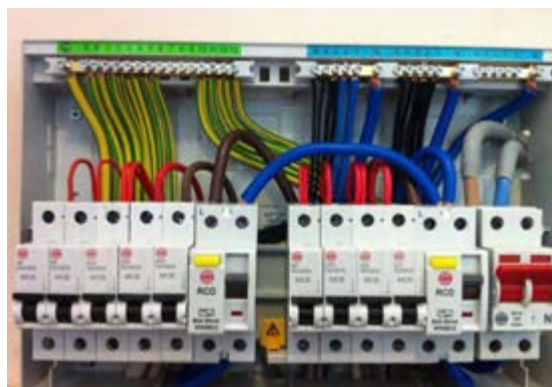
شکل ۹۲- سیم‌کشی نول و اتصال زمین
