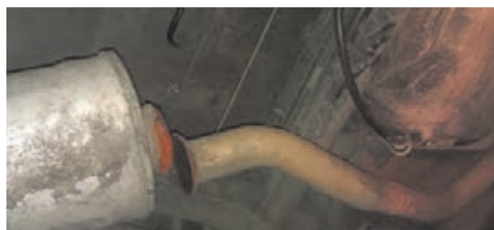
شکل ۳۳-۳- خراب شدن بست فلزی منبع آگزوز
