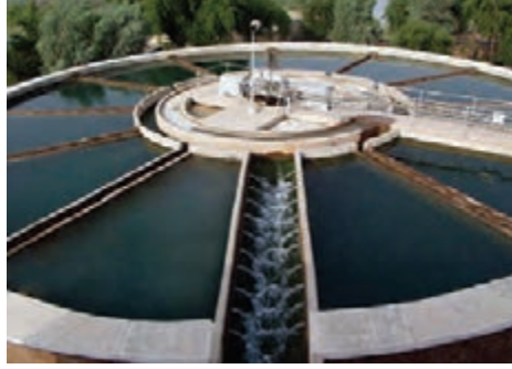
آب در تصفیه‌خانه
