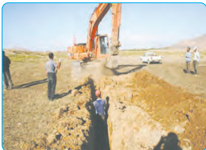
کندن زمین با بیل مکانیکی
