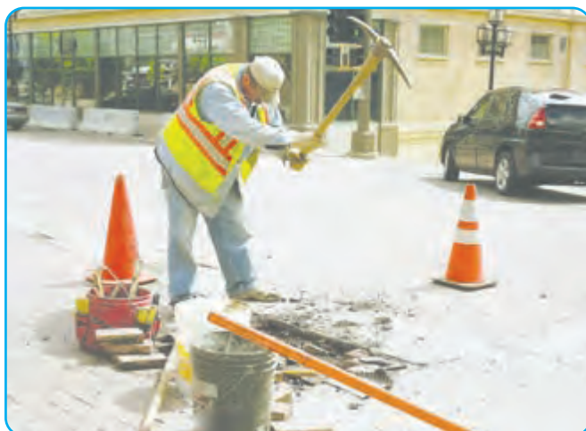
استفاده از کلنگ در کندن زمین
