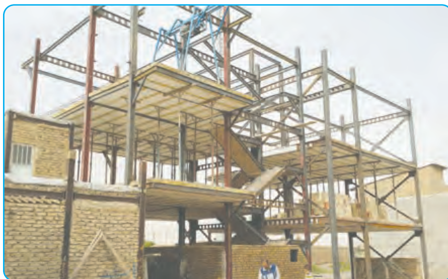
خانه‌ی در حال ساخت
