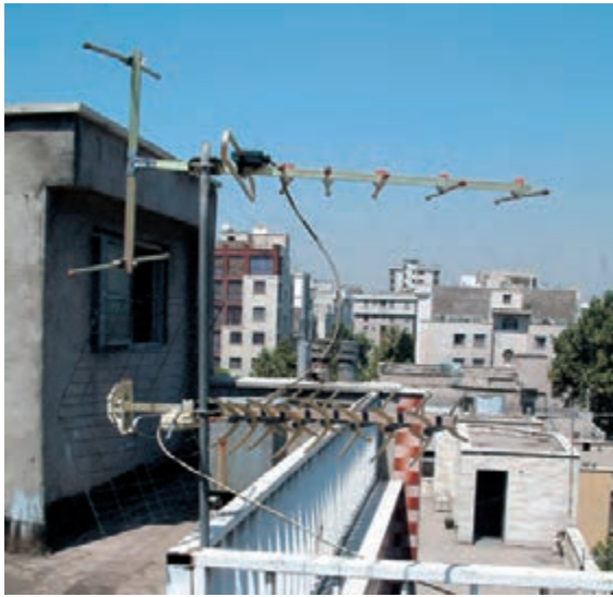
شکل ۱-۶۹- آنتن VHF و UHF روی دکل
