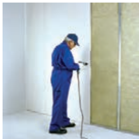
اجرای پانل‌ها در دو طرف دیوار
