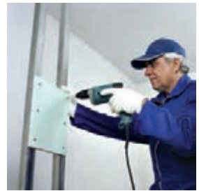
استادهای ردیف اول و دوم به وسیله برش‌هایی از پانل به یکدیگر وصل می‌شوند
