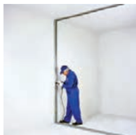
نصب استاد بر روی ساختار جانبی
