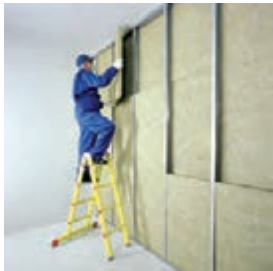
اجرای عایق پشم معدنی
