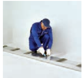
برش نوارهای عایق
