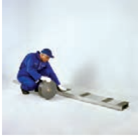
اجرای نوار عایق بر روی استاداها
