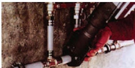
شکل ۵-۲۳ - اتصال پرسی
