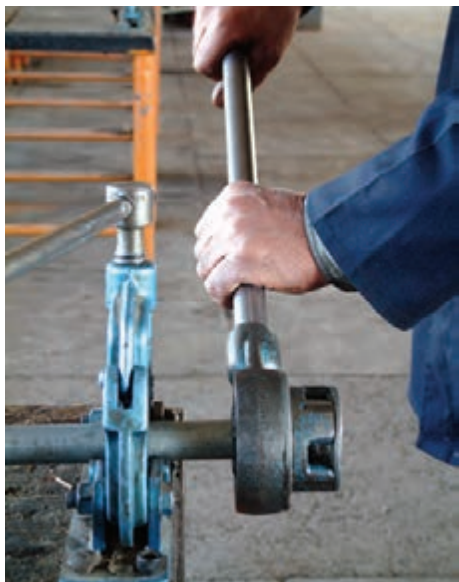
شکل ۴-۴۸- عمل حدیده کاری
