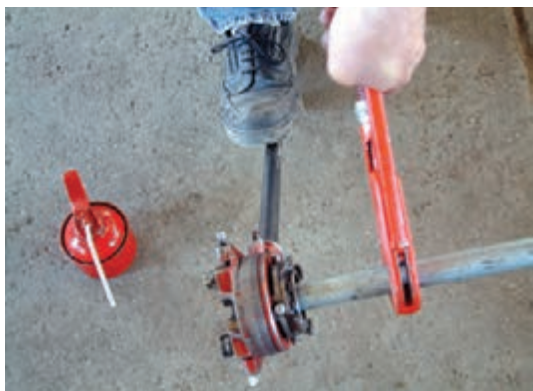
شکل ۱۲۰-۵- عمل حدیده کاری لوله
