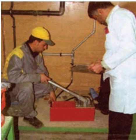
شکل ۵-۹۳- نحوه‌ی آزمایش با پمپ آزمایش دستی
