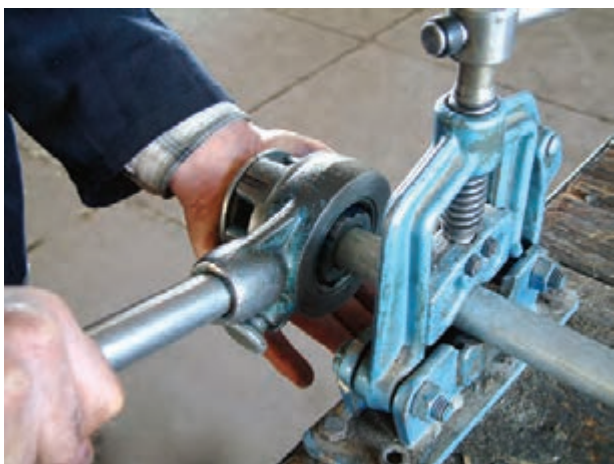
شکل ۴-۴۷- شروع دنده کردن لوله
