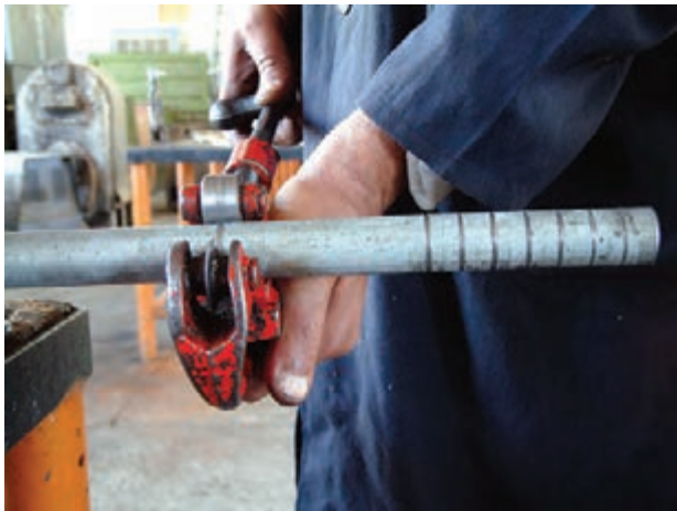
شکل ۱-۶۵- انتقال خطوط خط‌کشی شده به دور لوله
