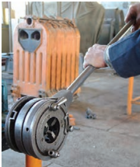
شکل ۴-۶۷- دنده کردن لوله
