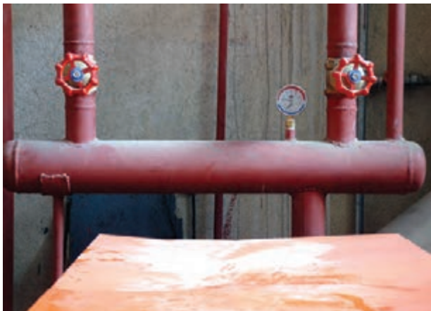
شکل ۳۲-۵- استفاده از اتصال جوشی در حرارت مرکزی
