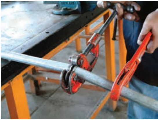
شکل ۱۱۷-۵- بریده شدن لوله و خاتمه‌ی کار
