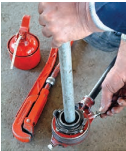
شکل ۱۱۸-۵- قرار دادن ضامن‌ها در جهت حدیده کردن و حرکت دادن لوله توأم با فشار در جهت دنده شدن لوله
