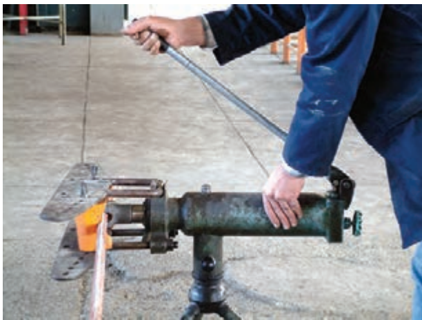
شکل ۱۱-۳- شروع خم کاری
