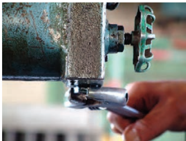
شکل ۱۴-۳ باز کردن درپوش تخلیه‌ی روغن
