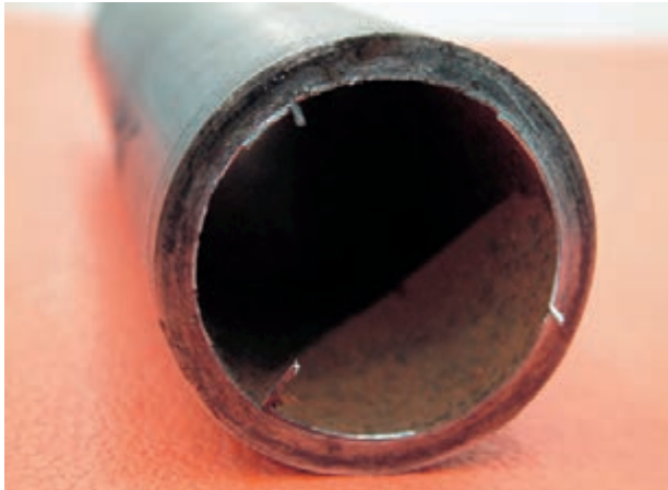
الف - لوله‌ی بریده شده به وسیله‌ی لوله‌بر
