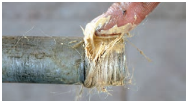
شکل ۵-۱۰۰- استفاده از مواد آب‌بندی
