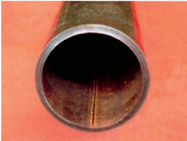
شکل ۱۳-۲- لوله‌ی برقو خورده
