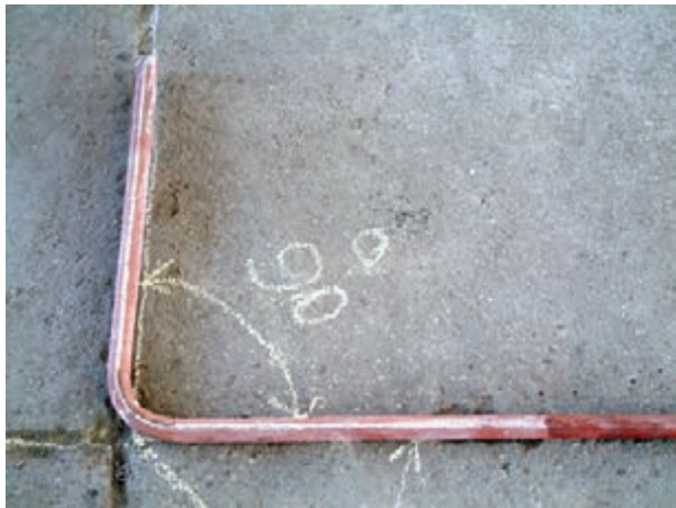
شکل ۲۶-۳- مقایسه‌ی لوله‌ی خم شده با گوشه‌های سنگ‌فرش کارگاه
