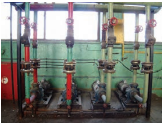
شکل ۵-۳- کاربرد لوله درزدار در لوله‌کشی شوفاز
