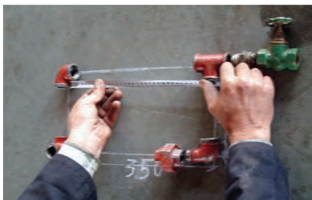
شکل ۱۴۹-۵- اندازه‌گیری طول لوله‌ها
