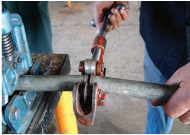
شکل ۳-۵۲- بریدن لوله‌ی محاسبه شده
