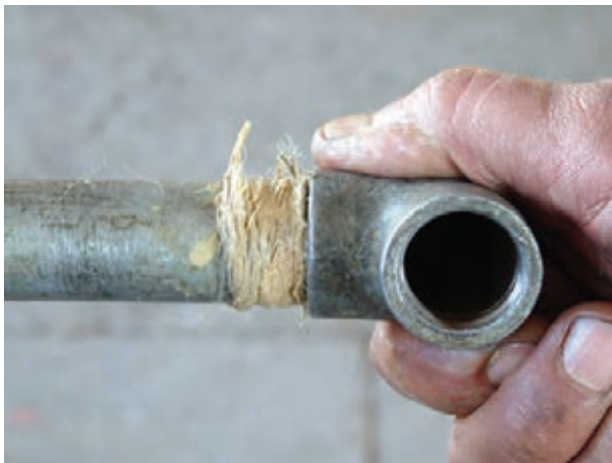
شکل ۵-۹۱- بستن فیتینگ بر روی سردنده
