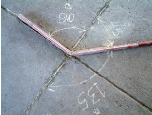
شکل ۲۹-۳- کنترل خم لوله‌های ۴۵ درجه
