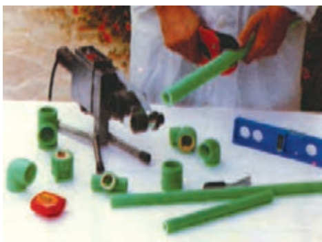
شکل ۲۷-۵- بریدن لوله به وسیله‌ی قیچی مخصوص
