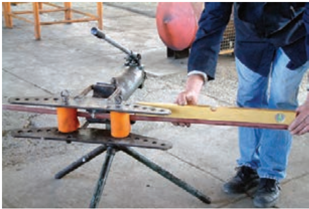
شکل ۳-۴۳- کنترل افقی بودن لوله در خم کاری
