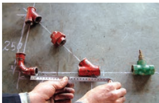
شکل ۱۳۴-۵- اندازه‌گیری لوله‌های مورد نیاز
