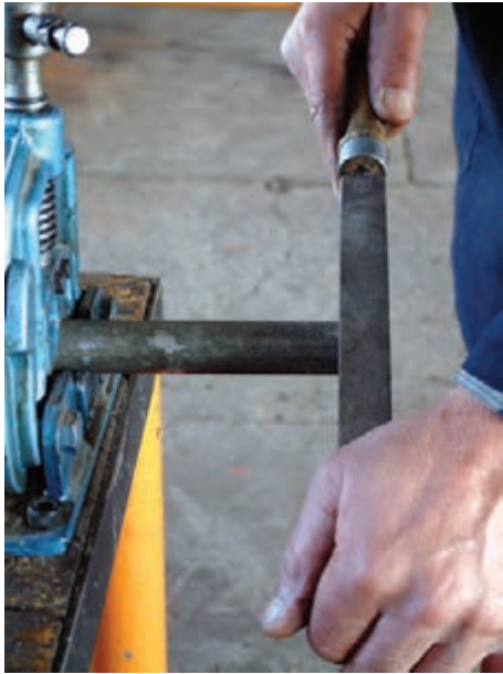
شکل ۲-۳- استفاده از سوهان تخت برای از بین بردن پلیسه‌ی سطح خارجی لوله
