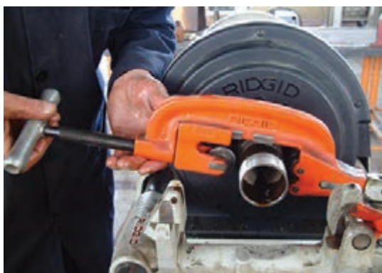
شکل ۴-۱۰۱- بریدن لوله به وسیله‌ی لوله‌بر
