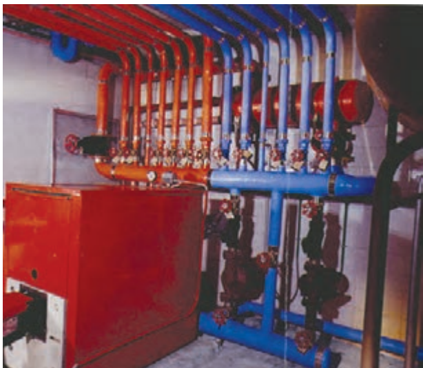
شکل ۴-۱۲- لوله‌های فولادی درزدار سیاه عایق‌پیچی شده در حرارت مرکزی
