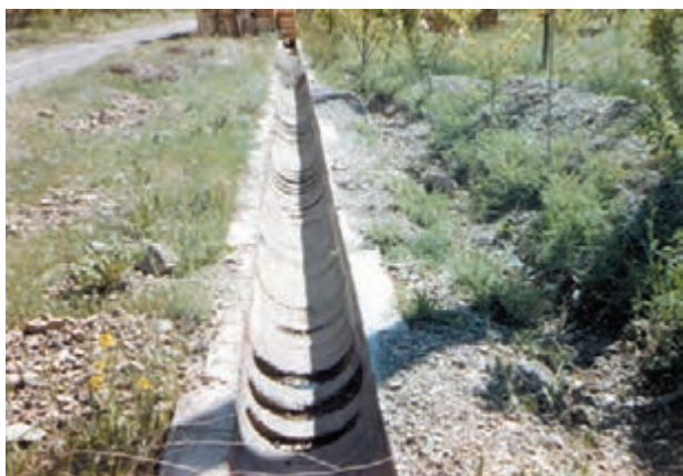
شکل ۲-۲- کانال با مقطع دوزنقه‌ای
