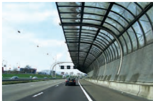
شکل ۷- دیوارهای جذب صدا در حاشیه بزرگراه‌ها
