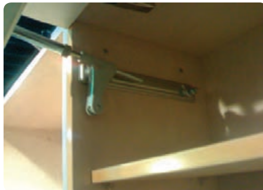
شکل ۶-۳۷ در کابینت نصب شده با نگه‌دارنده پمپی
