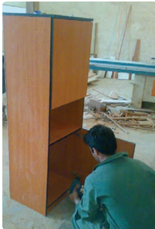
شکل ۱۲۲-۶ نصب در به کمد با لولا کابینتی فندار
