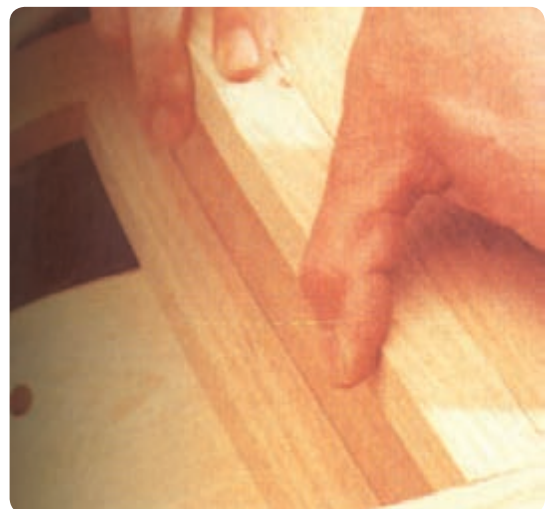
شکل ۶-۱۵۶ نصب ریل هدایت کشو
