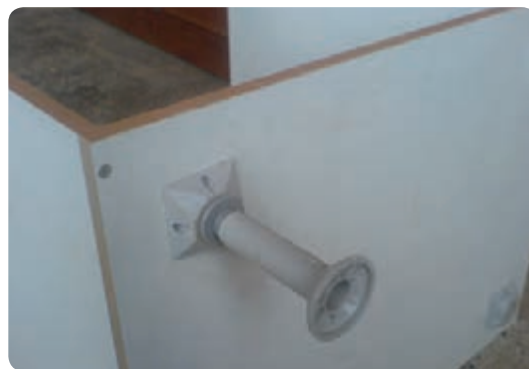
شکل ۱۱۵-۶ پایه نصب شده زیر کابینت
