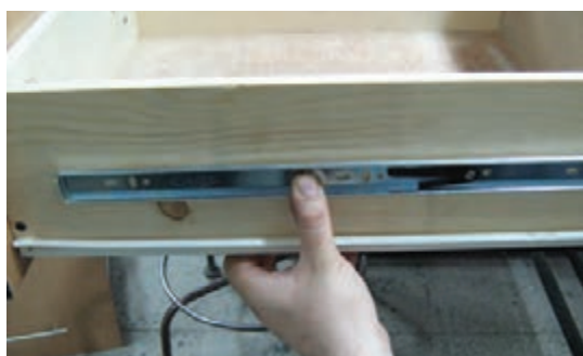
شکل ۷-۳۵ تعیین محل ریل بر روی بدنه کشو
