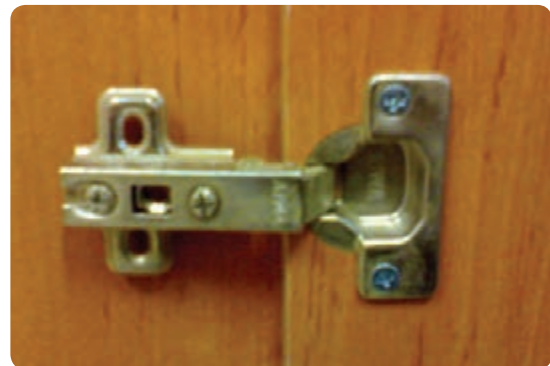
شکل ۶-۸۵ نصب کاسه لولا روی در کابینت
