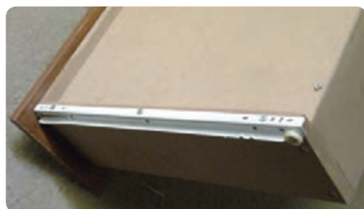
شکل ۶-۱۱۲ نصب ریل مکانیکی در زیر بدنه جعبه
