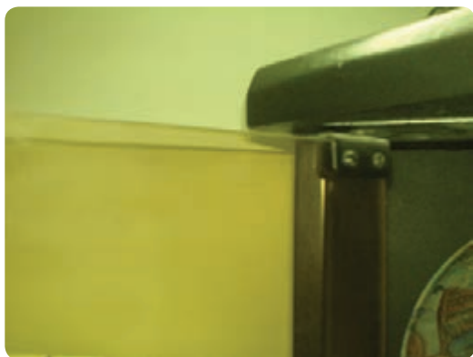
شکل ۶-۴۰ در شیشه‌ای با لولای پاشنه‌ای
