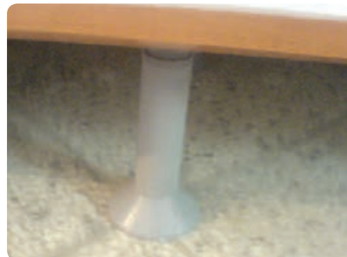
شکل ۶-۶۴ پایه نصب شده در زیر کابینت
