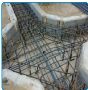
شکل ۱۴-۷- تکمیل میلگردگذاری محل اتصال ستون
