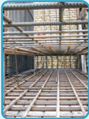
شکل ۱۵-۱- فولاد در بتن
