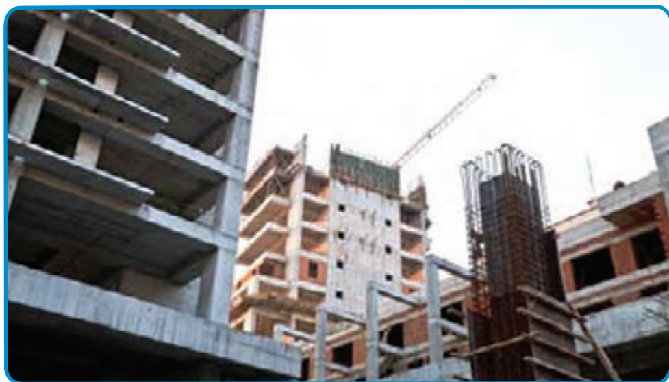
شکل ۱-۲- سازه‌های بتن آرمه
