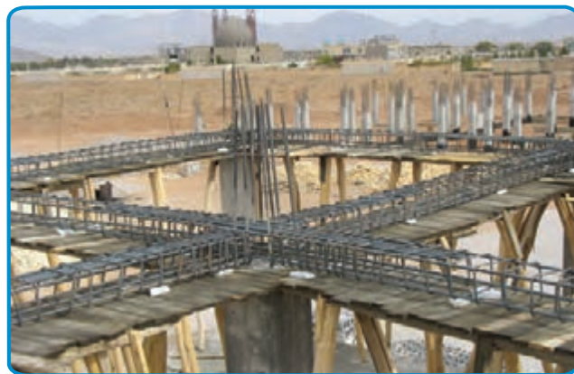
شکل ۷-۲۷- رعایت فاصله پوشش بتنی در کف
