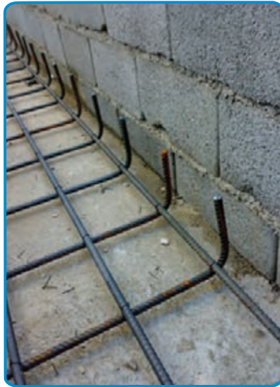
شکل ۱۰-۷- رعایت پوشش بتن در کف و بدنه
