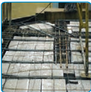
شکل ۷-۳۲- اجرای تیرهای فرعی کنسول
