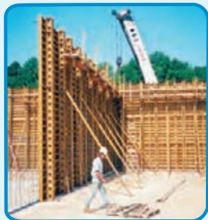
شکل ۱۹-۳- اجرای دیوار بتنی فایبر گلاس برای
