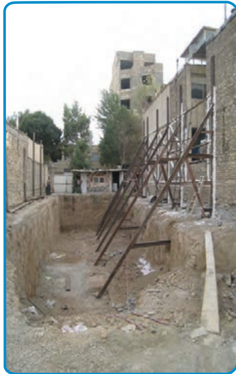
شکل ۳-۴- گودبرداری در زمین‌های محدود در تصاویر بالا اجرای سازه‌های نگهدارنده برای محافظت از ریزش ساختمان‌های مجاور نشان داده شده است
