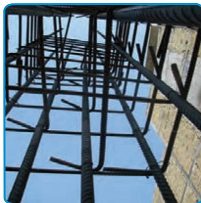
شکل ۱۹-۷- کار گذاشتن میلگردهای انتظار ستون، در فونداسیون
