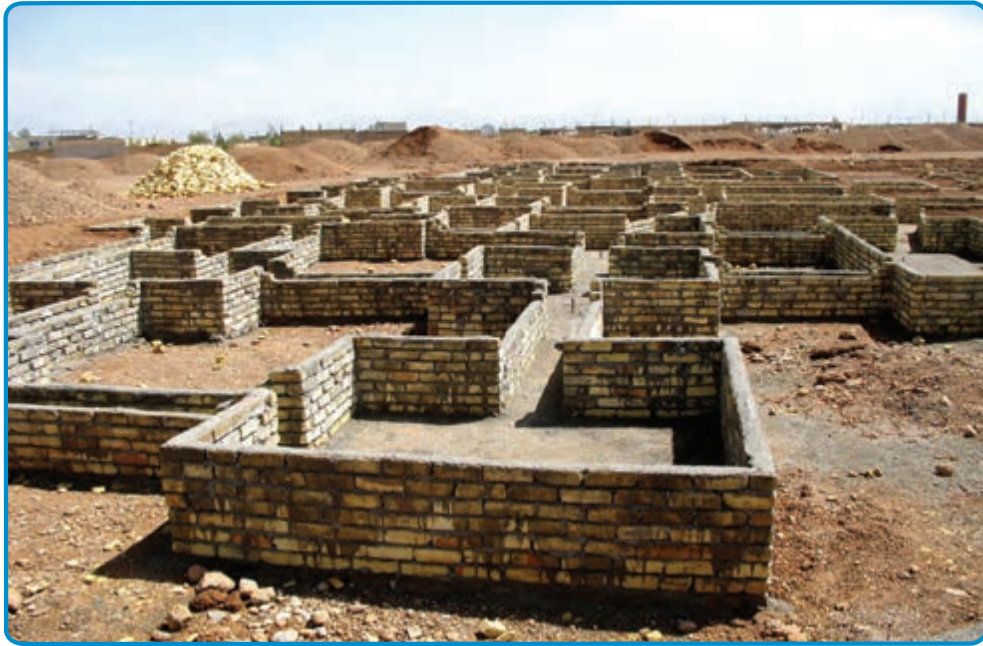
شکل ۱۵-۳- استفاده از قالب آجری برای اجرای پی
