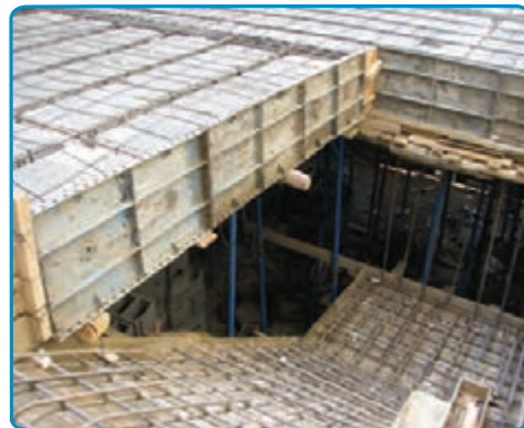
شکل ۴۰-۷- اجرای میلگردهای دال پله
