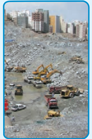
شکل ۳-۷- گودبرداری در زمین‌های نامحدود
