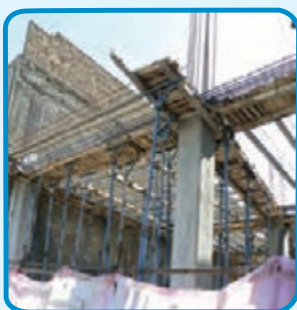
شکل ۳-۳۹- استفاده از قالب چوبی برای اجرای تیر
