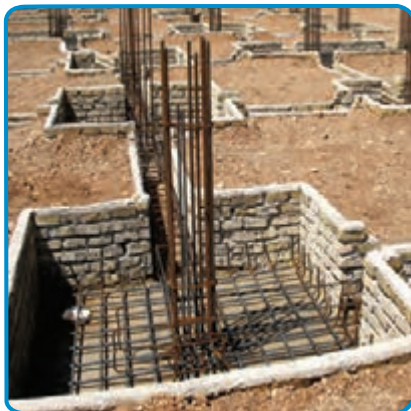
شکل ۴-۷- اجرای میلگردهای ریشه انتظار
