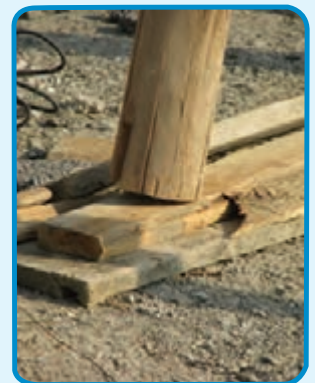
شکل ۳-۲۵- استفاده از گوه جهت تنظیم ارتفاع
