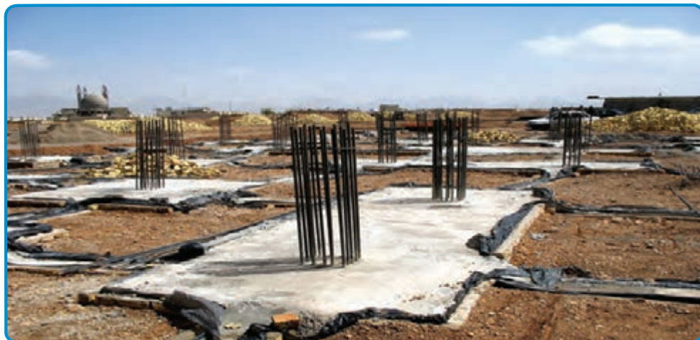
شکل ۱۰-۳- استفاده از پلاستیک در پی
