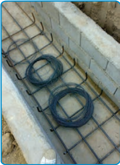
شکل ۹-۷- بهم بستن میلگردها
