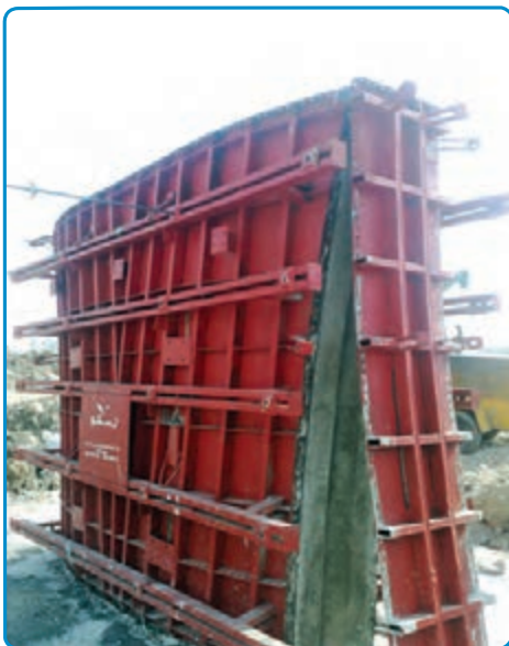
شکل ۳-۴۲- قالب برداری
