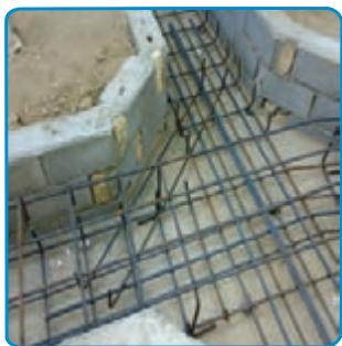
شکل ۱۳-۷- قرار دادن میلگردهای تقویتی پخها
