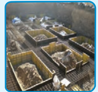
شکل ۳-۳۱- قالب فایبرگلاس برای اجرای پی
