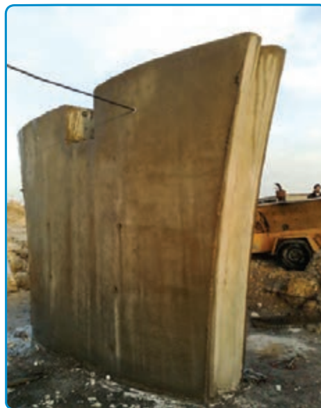
شکل ۳-۴۲- قالب برداری
