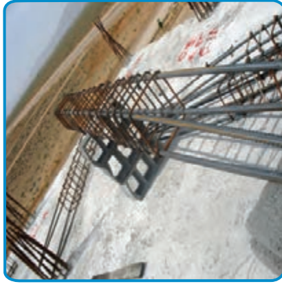
شکل ۷-۲۲- آماده کردن میلگردهای تیر روی زمین
