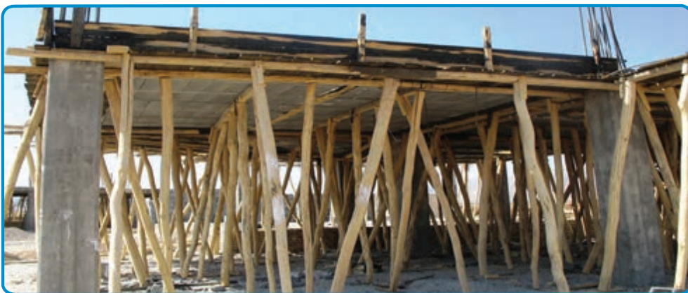
شکل ۳-۲۴- استفاده از شمع‌های چوبی جهت نگهداری قالب‌ها
