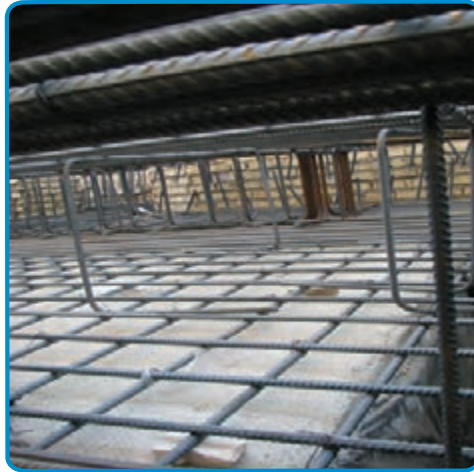
شکل ۳-۵۳- استفاده از خرک در میلگرد گذاری پی
