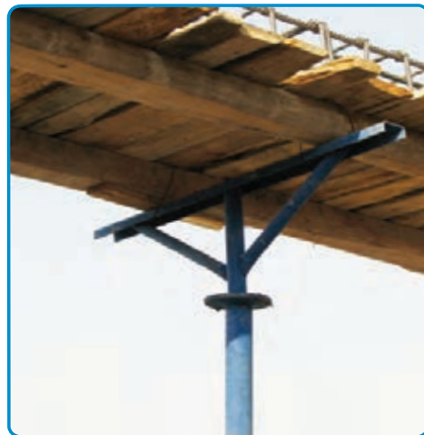
شکل ۳-۲۱- استفاده از شمع‌های فلزی جهت نگهداری قالب‌ها
