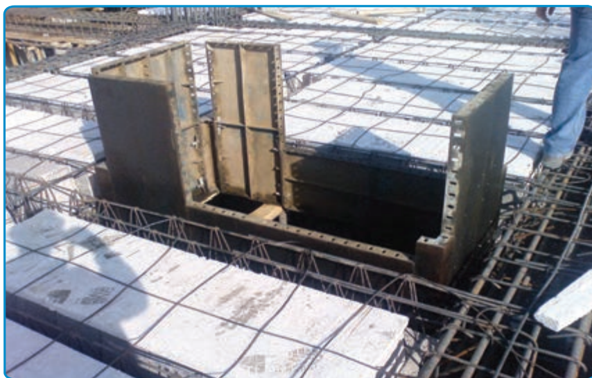
شکل ۳۵-۷- تکمیل قالب بندی
