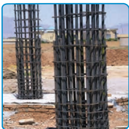
شکل ۱۶-۷- بتن ریزی ستون
