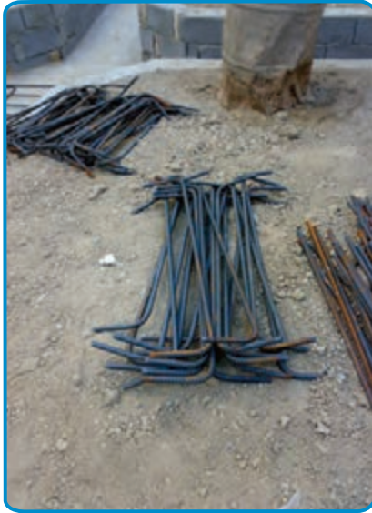
شکل ۷-۷- آماده کردن میلگردهای طولی و عرضی
