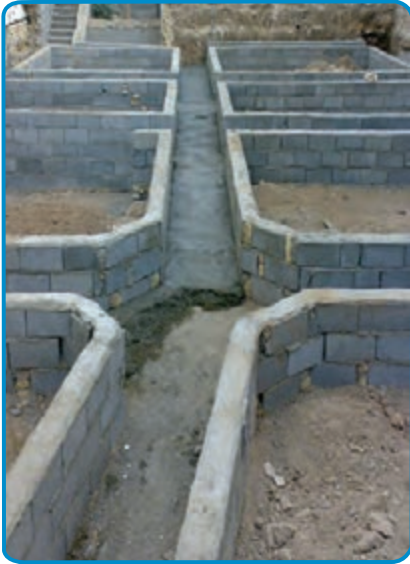
شکل ۶-۷- آماده سازی کف پی
