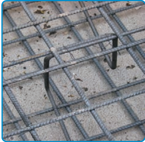
شکل ۳-۵۳- استفاده از خرک در میلگرد گذاری پی
