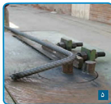
شکل ۶۴-۳- خم کردن میلگرد
