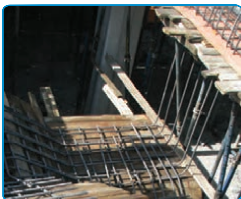
شکل ۴۱-۷- اجرای میلگردهای دال پله
