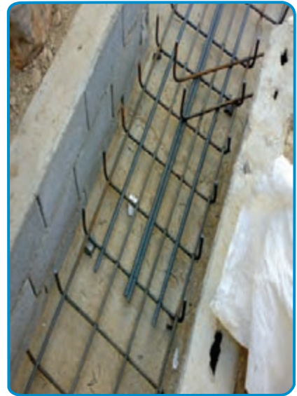
شکل ۱۱-۷- قرار دادن میلگردهای تقویتی
