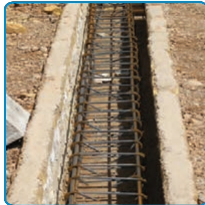
شکل ۵-۷- اجرای میلگرد شناژها
