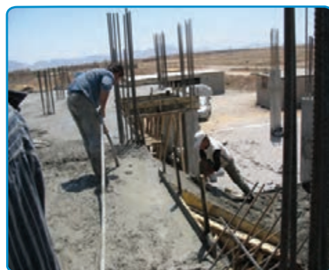
شکل ۴۲-۷- بتن ریزی دال پله
