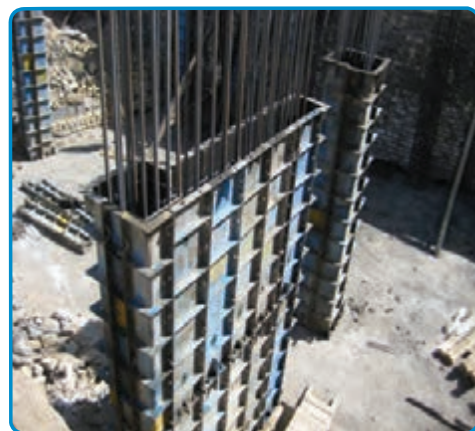
شکل ۳-۳۵- قالب فلزی برای اجرای دیوار بتنی
