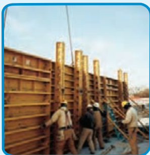
شکل ۳-۳۶- قالب فایبر گلاس برای اجرای دیوار بتنی
