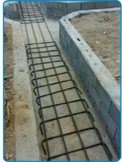
شکل ۸-۷- چیندن میلگردهای طولی و عرضی
