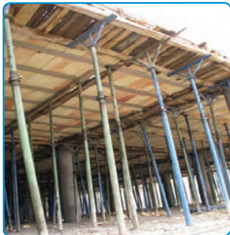
شکل ۳-۲۱- استفاده از شمع‌های فلزی جهت نگهداری قالب‌ها
