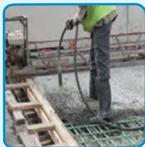
شکل ۱۴-۳- ویبراتور یا لرزاننده بتن داخل قالب
