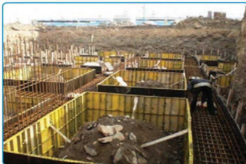
شکل ۱۸-۳- استفاده از قالب فایبرگلاس برای اجرای پی بتنی
