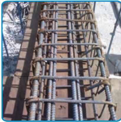
شکل ۷-۲۵- بستن خاموت ها با مفتول
