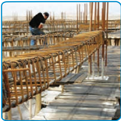
شکل ۷-۲۴- تنظیم فاصله بین خاموت ها
