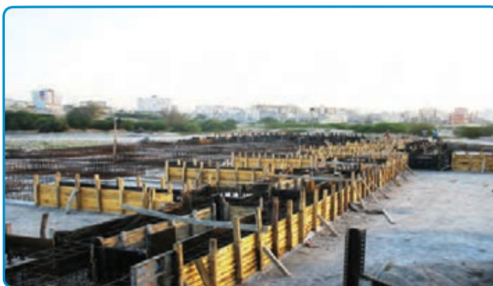
شکل ۳-۲۷- قالب چوبی برای اجرای پی
