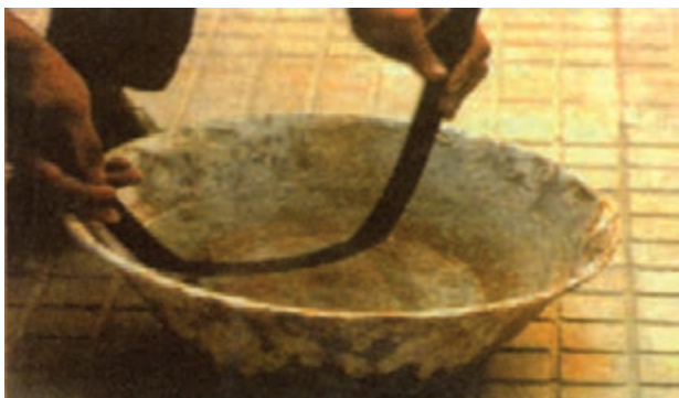
شکل ۴-۴۵- سرد کردن لوله پس از خم‌کاری
