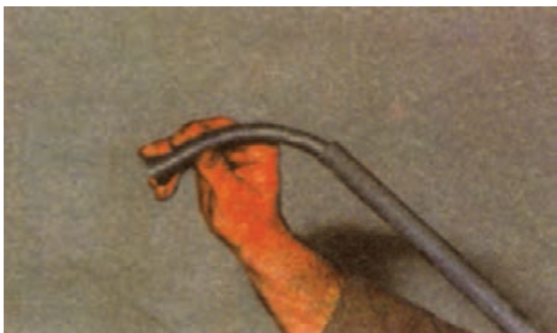
شکل ۴-۴۴- قرار دادن فنر خم‌کاری در داخل لوله
