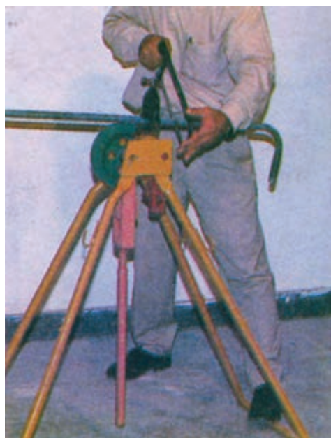
الف - بریدن لوله توسط اره
