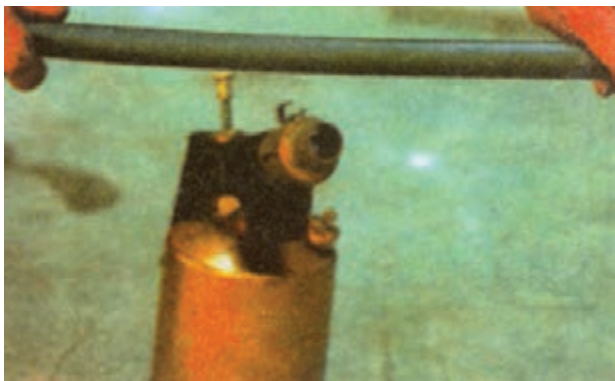
شکل ۴-۴۳- حرارت دادن لوله‌ی PVC
