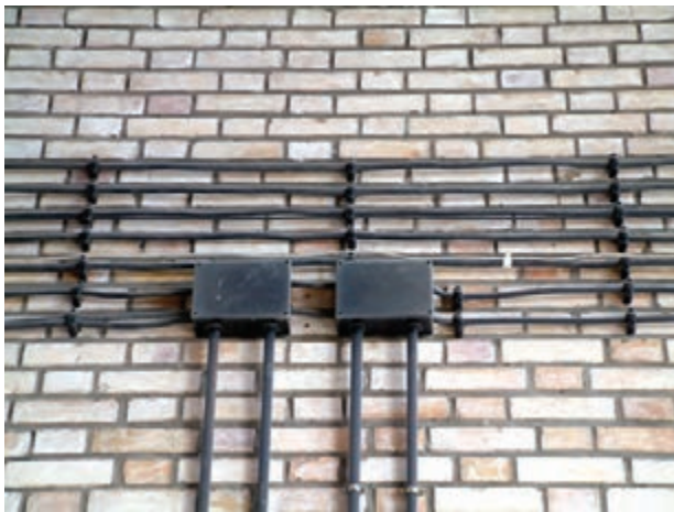
شکل ۵-۵۷- کابل‌کشی روی دیوار
