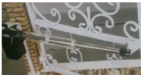
شکل ۴۸-۴ محل اتصال موتور به چارچوب در
