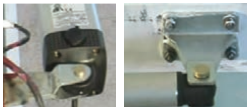
شکل ۴۸-۴ محل اتصال موتور به چارچوب در
