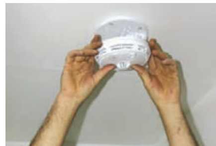
شکل ۱-۱۵ قرار دادن یک نوع آشکارساز روی پایه
