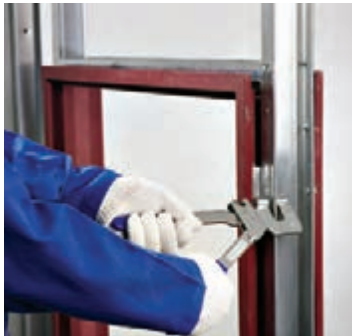
شکل ۱۳۰-۱- اتصال رانر نعل درگاه به استادهای پانچ
