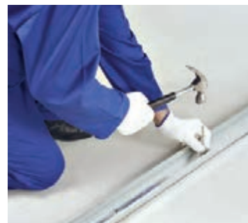
شکل ۴۲-۱- اتصال رانر به کف با رول پلاک
