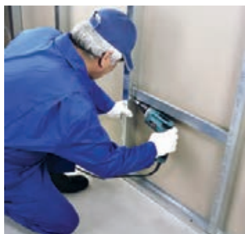
شکل ۱-۱۶۸- اتصال سازه پشتیبان به استادهای مجاور
