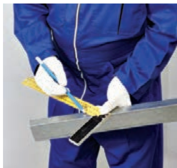
شکل ۱-۱۲۵- چهارچوب توسط پیچ LB در محل صفحات به استادها متصل می‌شود. شکل ۱-۱۲۶- علامت‌گذاری انتهای رانر نعل درگاه به صورت فارسی بر ( به اندازه ۲۰ سانتی‌متر) شکل ۱-۱۲۷- برش انتهای رانر نعل درگاه
