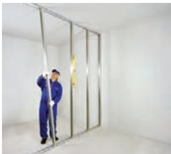
شکل ۱-۵۴ - اجرای استادها ( به صورت شاقولی)
