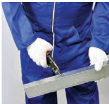
شکل ۱-۱۲۵- چهارچوب توسط پیچ LB در محل صفحات به استادها متصل می‌شود. شکل ۱-۱۲۶- علامت‌گذاری انتهای رانر نعل درگاه به صورت فارسی بر ( به اندازه ۲۰ سانتی‌متر) شکل ۱-۱۲۷- برش انتهای رانر نعل درگاه
