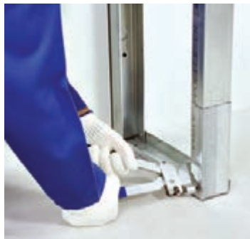
شکل ۱۱۷-۱- اتصال پایین استاد با پانچ
