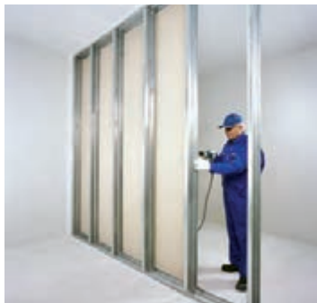
شکل ۸۶-۱- اجرای پانل‌ها در یک طرف دیوار
