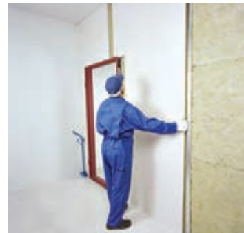
شکل ۱۴۳-۱- اجرای پانل چهارم دور چهار چوب
