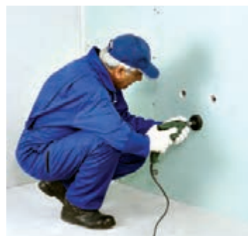
شکل ۱-۱۵۷- ایجاد خروجی‌های تأسیساتی به وسیله گردبر
