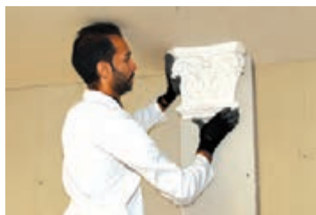
شکل ۲۴۲-۱- اتصال قطعه اول به ستون
