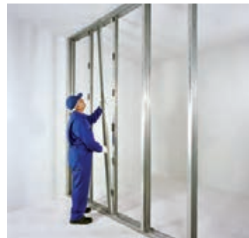
شکل ۸۴-۱- اجرای ردیف دوم استاداها
