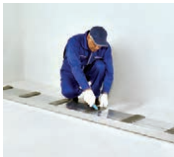
شکل ۸۲-۱- برش نوارهای عایق
