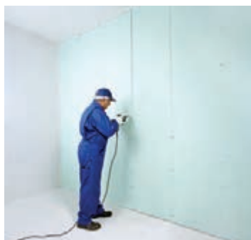
شکل ۱۰۱-۱- اجرای لایه دوم پانل‌ها
