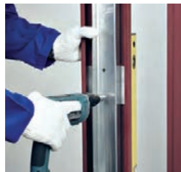
شکل ۱-۱۲۵- چهارچوب توسط پیچ LB در محل صفحات به استادها متصل می‌شود. شکل ۱-۱۲۶- علامت‌گذاری انتهای رانر نعل درگاه به صورت فارسی بر ( به اندازه ۲۰ سانتی‌متر) شکل ۱-۱۲۷- برش انتهای رانر نعل درگاه
