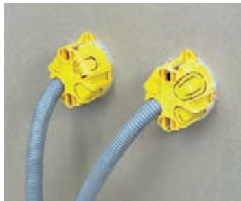
شکل ۱۷۷- گیره‌ها با پانل درگیر شده و قوطی برق در جای خود محکم می‌شود.
