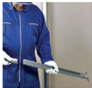
شکل ۱-۱۶۷- قطعه اتصال پشتیبان به صورت کشویی در سازه F47 قرار داده می شود.
