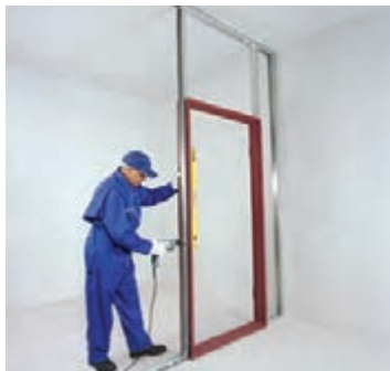
شکل ۱-۱۲۲- اتصال بالای استاد با پیچ LB شکل ۱-۱۲۳- اتصال چهارچوب به استاد شکل ۱-۱۲۴- اتصال چهارچوب به استاد اول دوم
