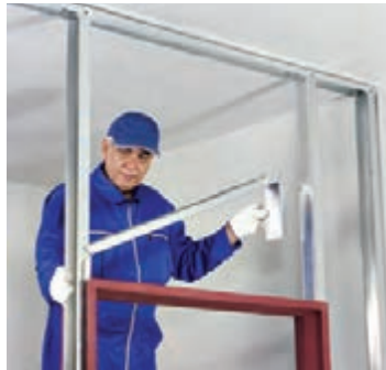
شکل ۱۲۹-۱- استقرار رانر نعل درگاه
