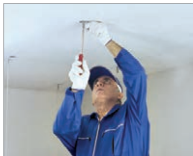
شکل ۳-۱۱۶- اتصال قطعه HT ۹۰ به سقف اصلی شکل ۳-۱۱۷
