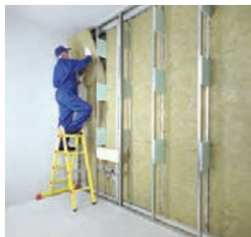
شکل ۹۹-۱- اجرای عایق معدنی
