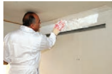
شکل ۲۳۷-۱- اجرای اندود گچ
