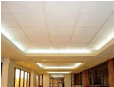
شکل ۱۱۰-۳- اجرای کامل سقف مشبک به روش قرینه‌سازی
