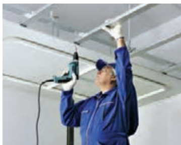
شکل ۳-۵- سقف کاذب با صفحات روکش دار گچی
