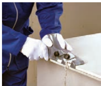
شکل ۱-۱۹۱- پخ زدن لبه‌ها
