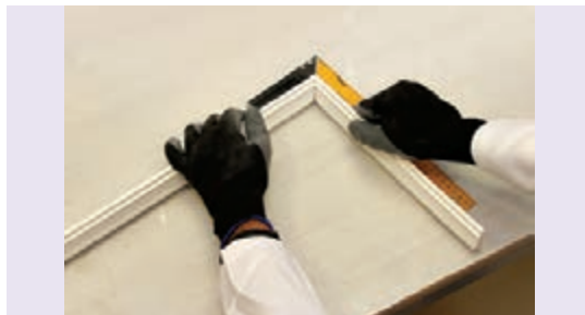
شکل ۲۲۹-۱- کنترل گونیا بودن قطعات قبل از نصب
