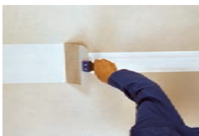
شکل ۳-۸۲- قرار دادن نوار درزگیر بر روی بتونه
