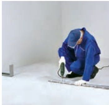
شکل ۱۱۴-۱- نصب رانر کف
