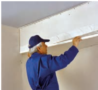
شکل ۸۴-۳- قرار دادن نوار درزگیر بر روی بتونه
