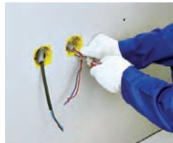
شکل ۱۷۶- گیره‌ها توسط پیچ گوشتی جمع می‌شوند.
