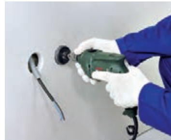
شکل ۱۷۳- خروجی‌های تأسیساتی به وسیله گردبر ایجاد می‌شوند.
