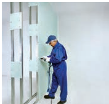
شکل ۹۸-۱- اجرای پانل‌ها در یک طرف دیوار
