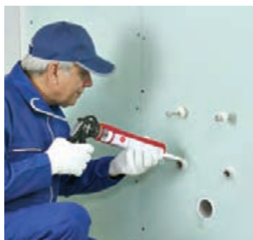
شکل ۱-۱۵۹- اجرای خمیر درزبند در اطراف خروجی‌های تأسیساتی
