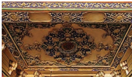
شکل ۲-۱- گچ بری سقف
