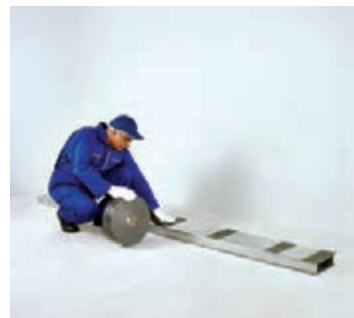
شکل ۸۱-۱- اجرای نوار عایق بر روی استاداها
