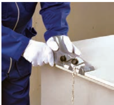
شکل ۳-۸۰ پیچ زدن
