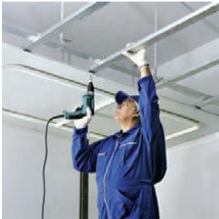
شکل ۳-۶۷ اتصال پانل به زیرسازی توسط پیچ
