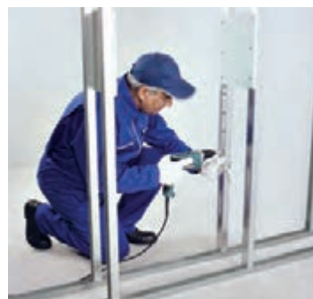
شکل ۱-۱۵۴- اتصال قطعات نبشی L۲۵ به استادهای مجاور
