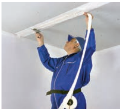
شکل ۳-۸۱- اجرای لایه بتونه در محل درز (کاردک در جهت عمود بر درز کشیده می شود تا بتونه کاملاً در درز نفوذ کند).
