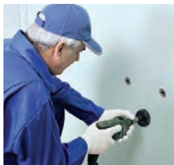
شکل ۱۰۲-۱- ایجاد خروجی تأسیسات به وسیله گرد بر
