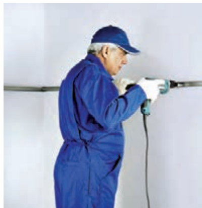
شکل ۳-۴۵- نصب سازه تراز
