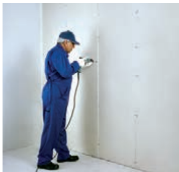
شکل ۸۹-۱- اجرای لایه دوم پانل‌ها
