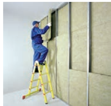
شکل ۸۷-۱- اجرای عایق پشم معدنی
