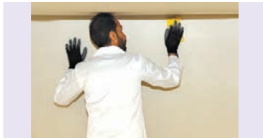
شکل ۲۲۵-۱- تمیز کردن سطح کار
