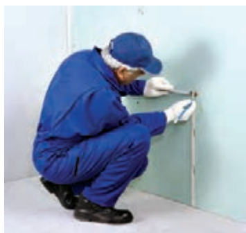
شکل ۱-۱۵۶- تعیین محل خروجی‌های تأسیساتی
