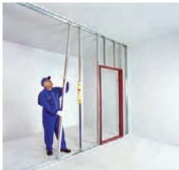
شکل ۱-۱۳۶- اجرای استادهای دیوار
