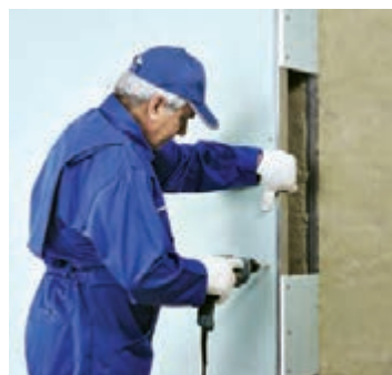
شکل ۱۰۰-۱- اجرای پانل‌ها در طرف دیگر دیوار
