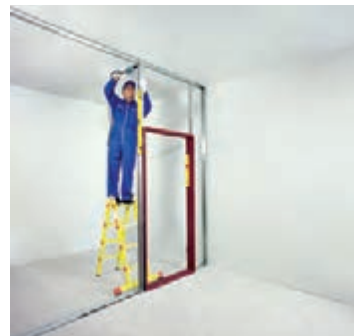
شکل ۱-۱۲۲- اتصال بالای استاد با پیچ LB شکل ۱-۱۲۳- اتصال چهارچوب به استاد شکل ۱-۱۲۴- اتصال چهارچوب به استاد اول دوم
