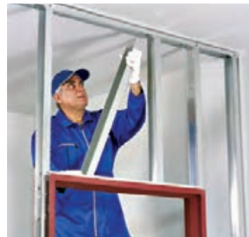
شکل ۱۳۱-۱- استقرار استادهای کتیبه
