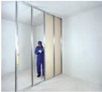
شکل ۱-۶۲- اجرای پانل‌ها در یک طرف دیوار
