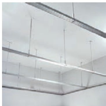
شکل ۳-۵۹- سازه‌های باربر تکمیل شده
