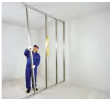
شکل ۸۳-۱- اجرای ردیف اول استاداها (به صورت شاقولی)
