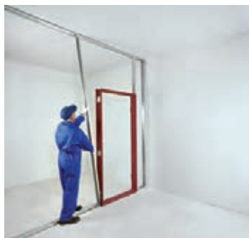
شکل ۱۲۰-۱- نصب استاد دوم
