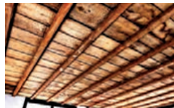
شکل ۳-۱- سقف کاذب چوبی
