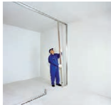
شکل ۱۱۶-۱- نصب استاد اول
