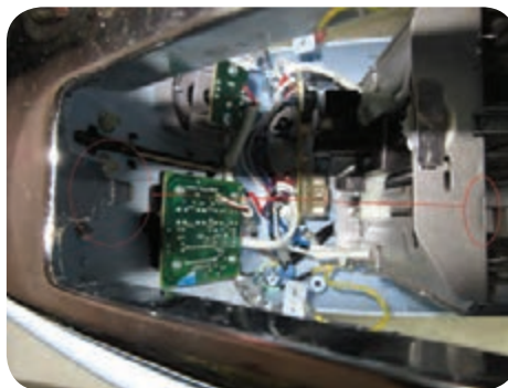
شکل ۶-۵۷ محل اتصال قسمت‌های فلزی
