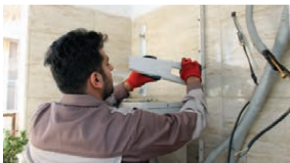
شکل ۷- نصب یونیت خارجی
