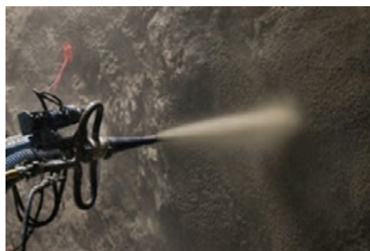
شکل ۲۸- نصب جرم با روش پاشش
