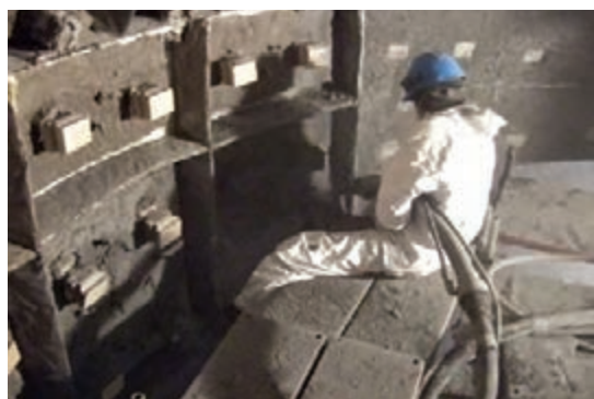
شکل ۲۸- نصب جرم با روش پاشش
