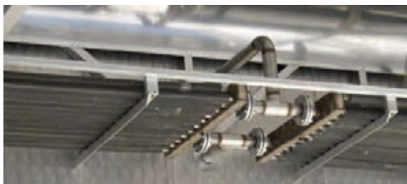
شکل ۴۱- انتقال حرارت کویل‌ها با هوای اطراف خود
