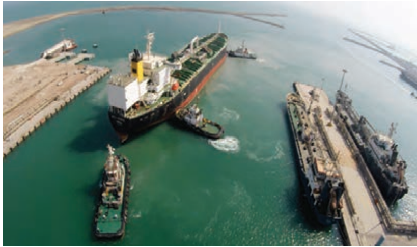
شکل ۲۰- عملیات پهلو دهی کشتی به اسکله
