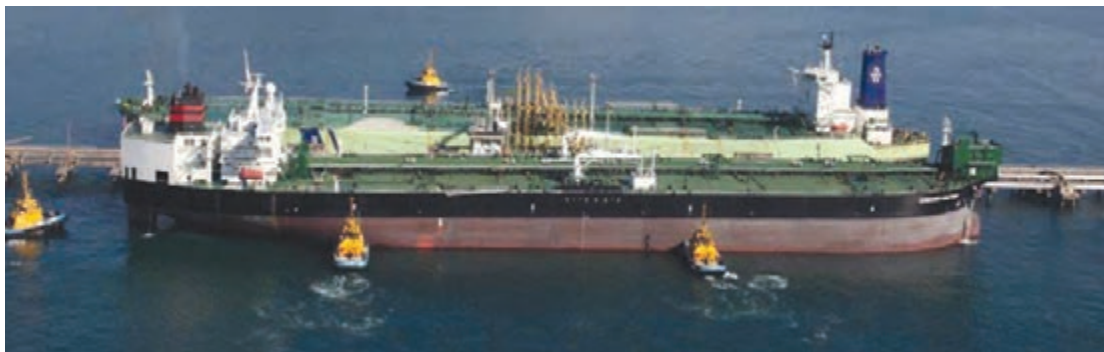
شکل ۲۷- استفاده از چهار یدک کش برای پهلو دهی یک سوپر تانکر
