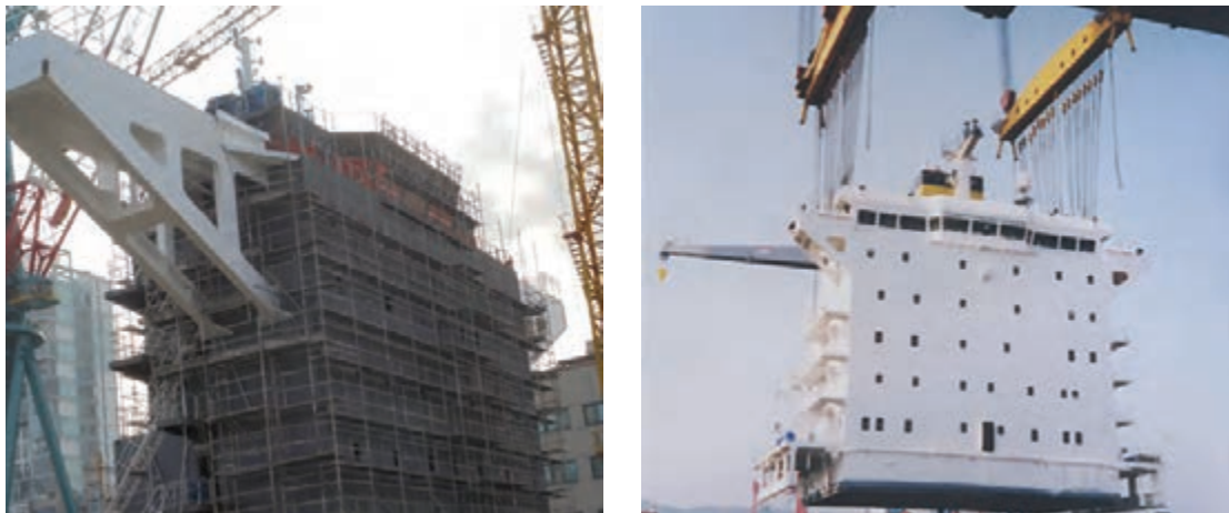
شکل ۱۶- ساختمان محل استراحت خدمه و پل فرماندهی
