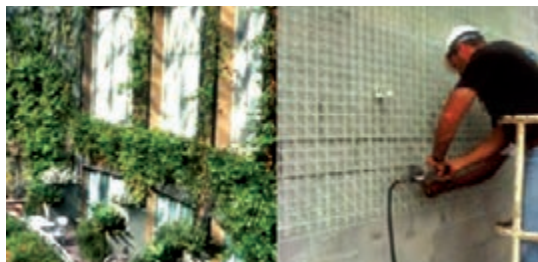
نصب پانل‌ها روی دیوار
