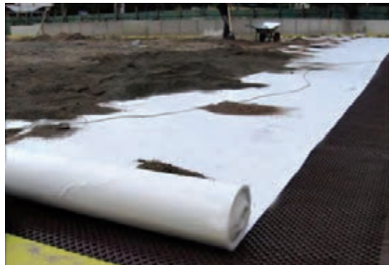
قرارگیری رول ژئوتکستایل در زیر بستر رشد
