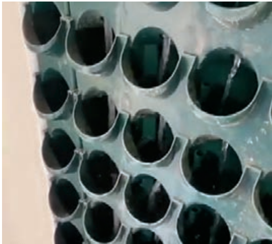
سیستم آبیاری در پانل‌های دیوار سبز
