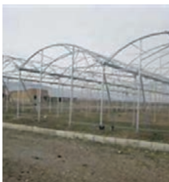
اسکلت گلخانه به سبک تونل - پیوسته
