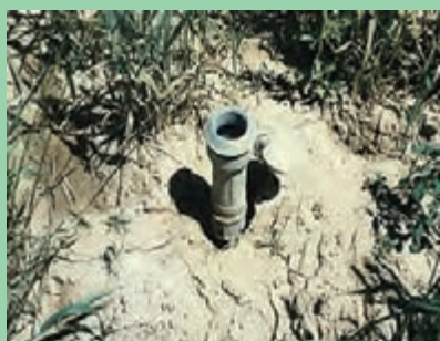
شکل ۱۲- شیر خودکار، رایزر و آبپاش
