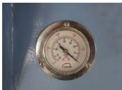
شکل ۱۸- روشن کردن پمپ وکیوم
