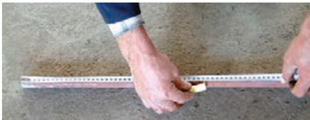
شکل ۳-۵۴- خط‌کشی لوله و تعیین محل‌های خم
