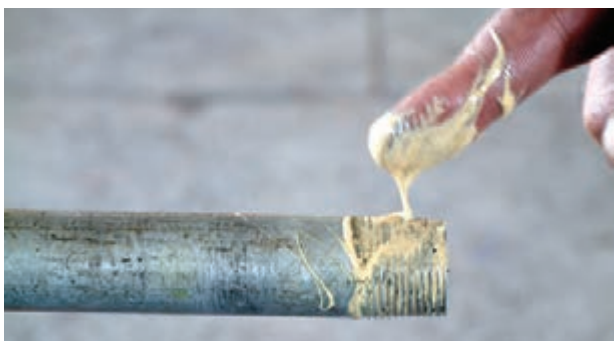
شکل ۵-۵۳- مالیدن خمیر بر روی سردنده
