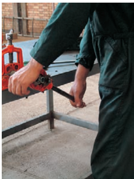
شکل ۴-۱۱۲- حديدكاري متناسب با قطر لوله
