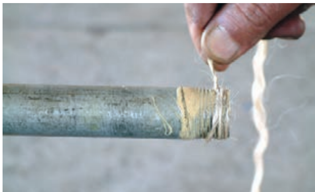
شکل ۵-۵۴ پیچیدن کنف بر روی سردنده
