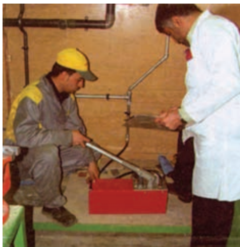
شکل ۵-۹۳- نحوه‌ی آزمایش با پمپ آزمایش دستی
