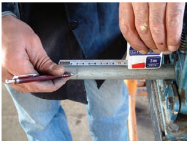
شکل ۱-۵۳- مشخص کردن محل برش
