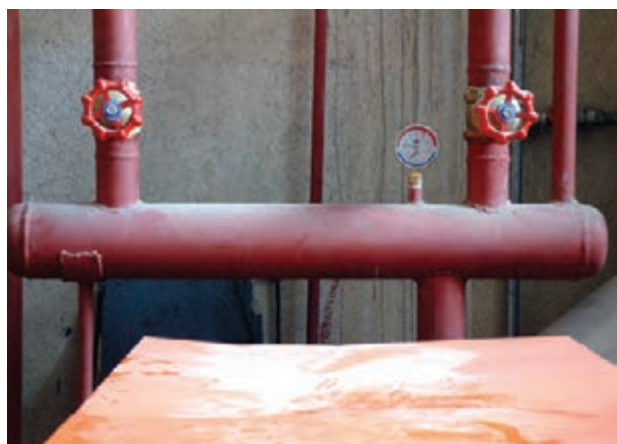
شکل ۳۲-۵- استفاده از اتصال جوشی در حرارت مرکزی
