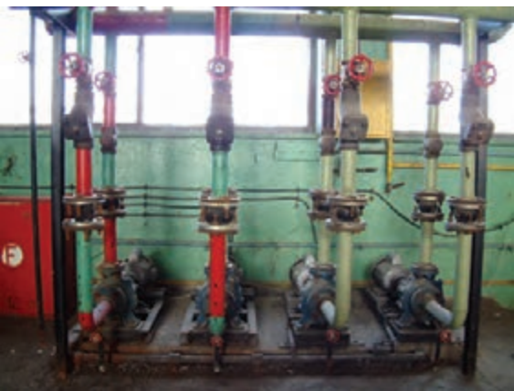
شکل ۵-۳- کاربرد لوله درزدار در لوله‌کشی شوفاز
