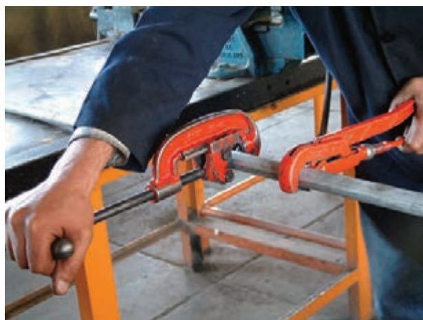
شکل ۱۱۶-۵- ادامه‌ی برش‌کاری لوله
