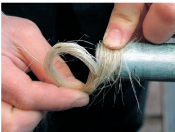
شکل ۵-۱۳۸- پیچیدن مواد آب‌بندی به سردنده‌ها
