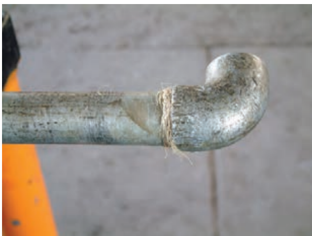
شکل ۹۸-۵- فیتینگ بدون لبه
