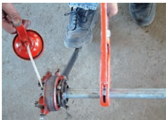
شکل ۵-۱۲۱ استفاده از روغن در جريان حديدۀ کارى
