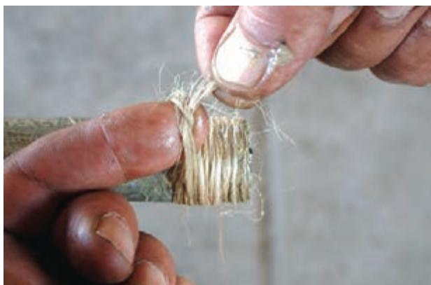
شکل ۵-۵۵ گره زدن انتهای پیچیدن کنف
