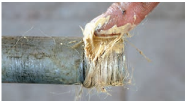
شکل ۵-۵۷ مالیدن خمیر آب بندی بر روی کنف
