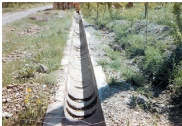
شکل ۲-۲- کانال با مقطع دوزنقه‌ای
