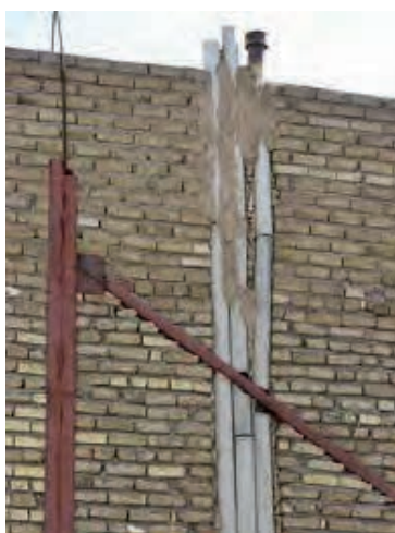
شکل ۴-۶ الف دودکش نادرست
