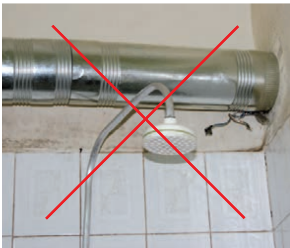
شکل ۳-۱۱ عبور غیر مجاز دودکش
