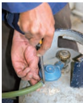
شکل ۱-۶۶ ب سفت کردن بست
