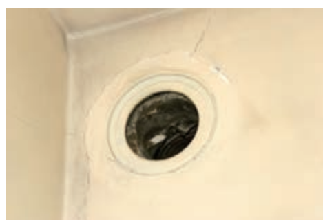
شکل ۱-۴ دودکش در محل نصب آب گرم کن.
