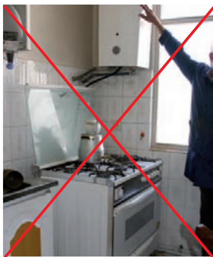
شکل ۱-۶ نصب نادرست آب گرم کن.
