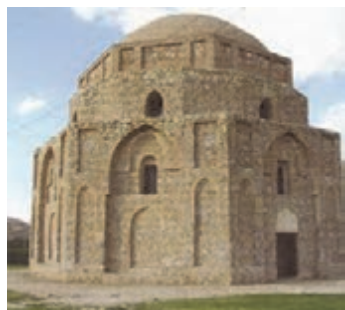
شکل ۱۰۶-۲- کرمان، گنبد جبلیه، سنگ لاشه و ملات
