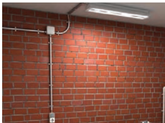
شکل ۳-۳۲- نمونه‌هایی از سیم‌کشی روکار
