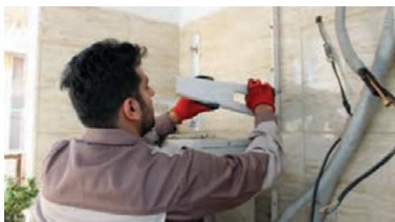
شکل ۷- نصب یونیت خارجی
