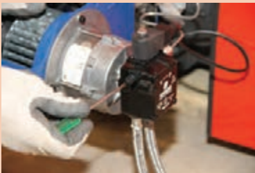
هواگیری پمپ
