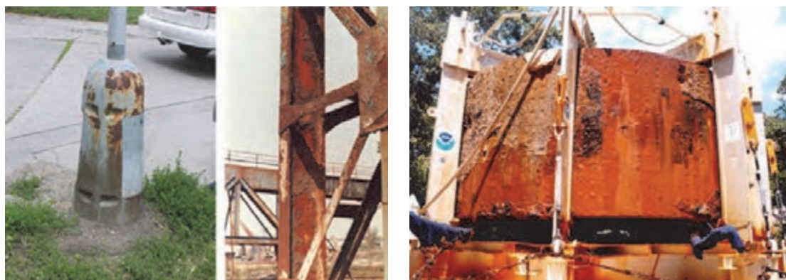
شکل ۵- نمونه‌هایی از خوردگی جو
