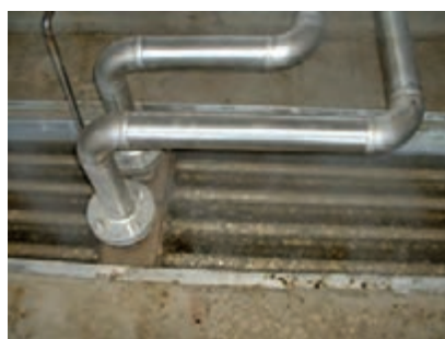
شکل ۶۱- کویل‌های حرارتی برای گرم کردن هوای کوره
