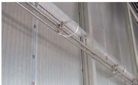
شکل ۳۵- محل قرارگیری اسپری بخار در کوره
