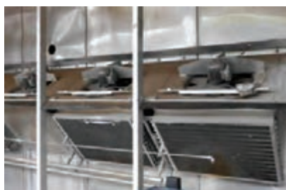
شکل ۴۰- انتقال حرارت کویل‌ها به وسیله فن‌ها
