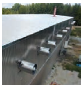
شکل ۴۳- نصب دمنده در خارج از کوره
