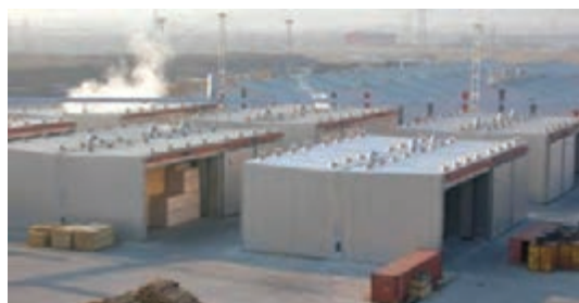
شکل ۲۹- کوره‌های چوب خشک‌کنی ساخته شده با آلومینیوم
