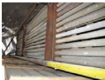
شکل ۳۸- نحوه قرارگیری کویل‌های حرارتی
