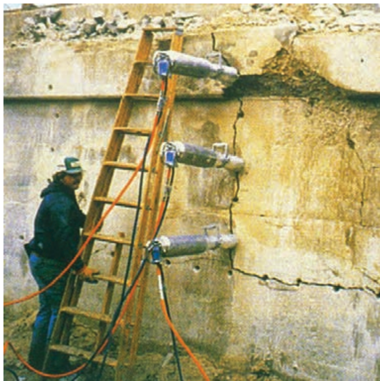
ابزار برش هیدرولیک سنگ
