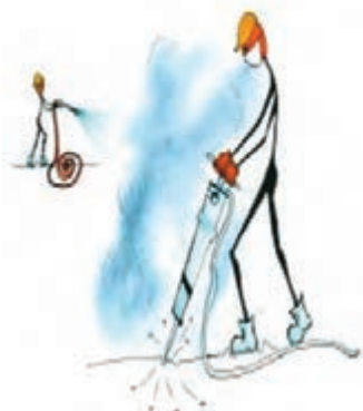
استفاده از اسپری آب جهت کاهش گردوغبار
