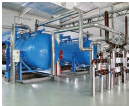
شکل ۱۲- سیستم زمستانه کردن روغن‌ها
