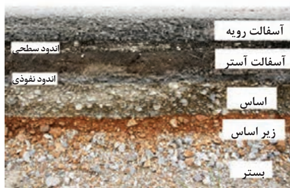
شکل ۲۰- لایه‌های مختلف یک روسازی آسفالتی
