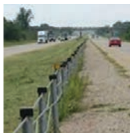
شکل ۴۶- نمونه هایی از اتصال کابل به پایه ها
