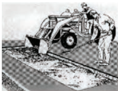
برداشتن لایه های آسفالتی و اساس
