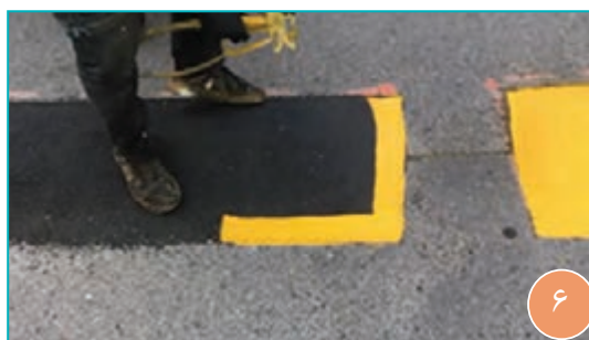
شکل ۷- مراحل اجرای سرعت گیر آسفالتی
