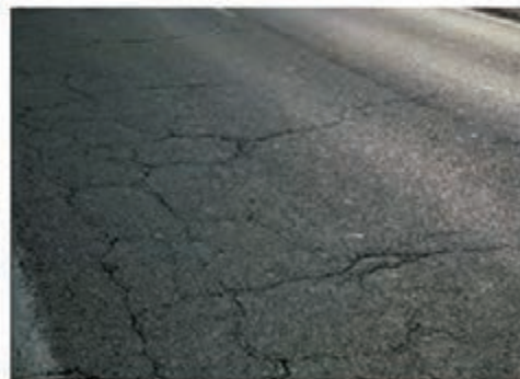
شکل ۳- ترک‌های بلوکی
