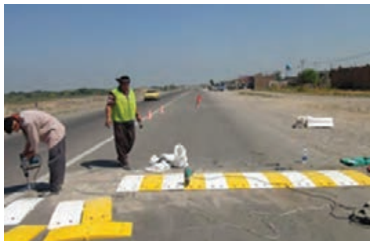
شکل ۱۵- نحوه نصب سرعت گیر پلاستیکی با استفاده از پیچ و مهره
