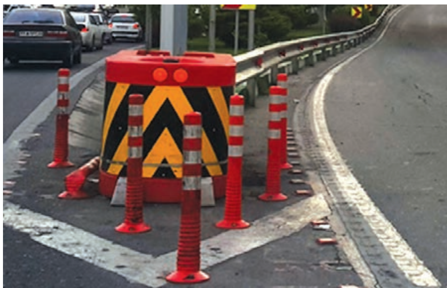
شکل ۲۱ - اجزای ضربه گیر ریلی در تهران
