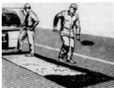
پر کردن محدوده لکه گیری با آسفالت
