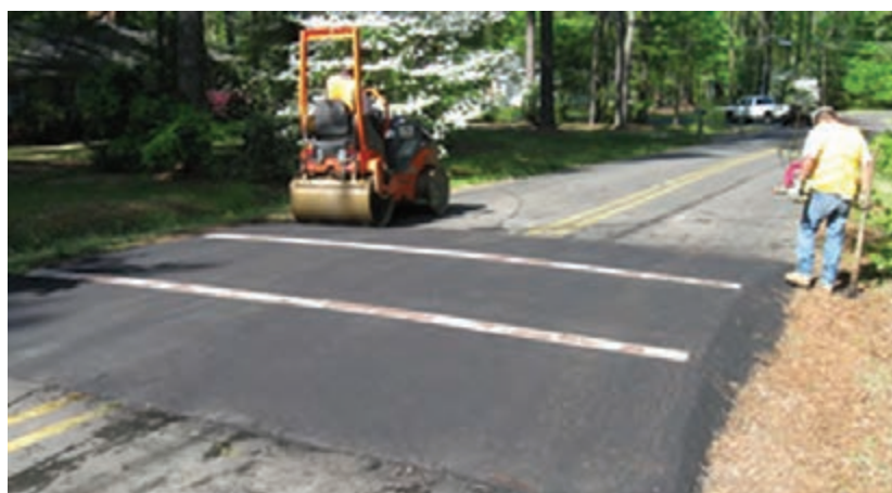
شکل ۲۴- غلتک زدن سطح سرعت کاه
