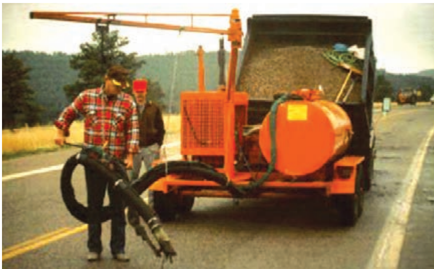
شکل ۴۴- تجهیزات تزریق فشاری
