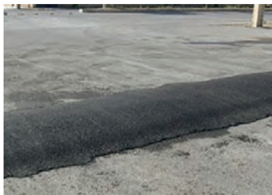
شکل ۹- ساخت سرعت گیر غیر استاندارد بتنی و آسفالتی
