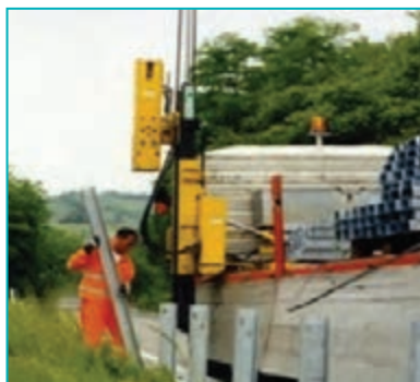
شکل ۳۴- چکش هیدرولیکی گاردریل کوب
