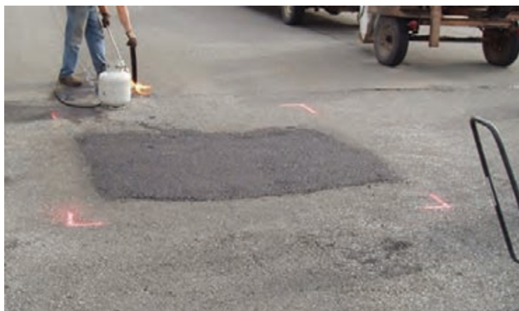
شکل ۳۹- نحوه مشخص کردن محدوده خرابی برای لکه‌گیری
