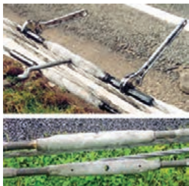
شکل ۴۸ - تنظیم کشش کابل
