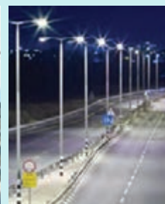
شکل ۷۶- ایمن سازی چراغ برق
