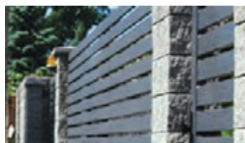
شکل ۱۱- دیوارهای حایل ژئوبلوک
