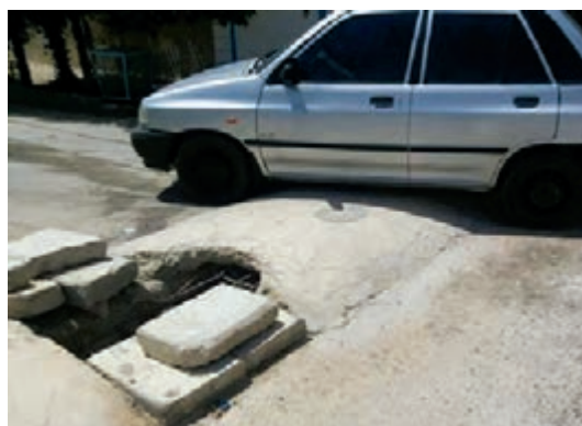
شکل ۹- ساخت سرعت گیر غیر استاندارد بتنی و آسفالتی
