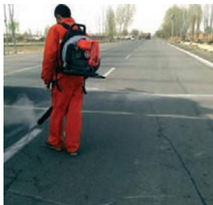
شکل ۲۰- نمونه‌ای از دمنده‌های هوای قابل حمل
