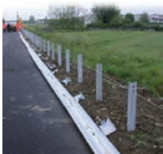
شکل ۴۳- نمونه‌ای از نصب پایه‌های گاردریل با ریسمان‌کشی
