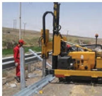
شکل ۴۲- پایه‌کوبی بعد از ریلی کردن سپری‌ها
