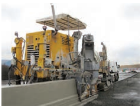
۵۰- ساخت نیوجرسی (بتن درجا به روش اتوماتیک)
