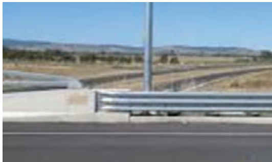
شکل ۸۲ - ناحیه انتقالی حفاظ سه موج به نیوجرسی
