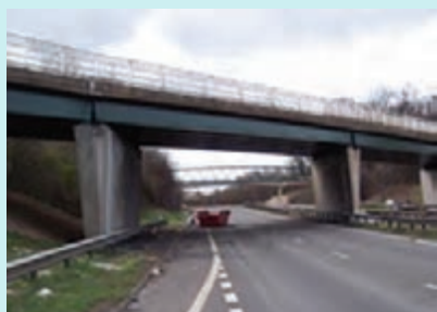
شکل ۷۸- ایمن سازی پایه های پل
