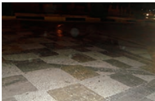
شکل ۳۲- دید بسیار ضعیف رنگ های ترافیکی بر روی سرعت کاه در شب
