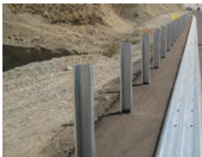
شکل ۴۲- پایه‌کوبی بعد از ریلی کردن سپری‌ها
