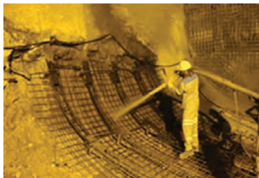
شکل ۲۱- اجرای بتن پاشی (شاتکریت) در بدنه تونل نیایش تهران
