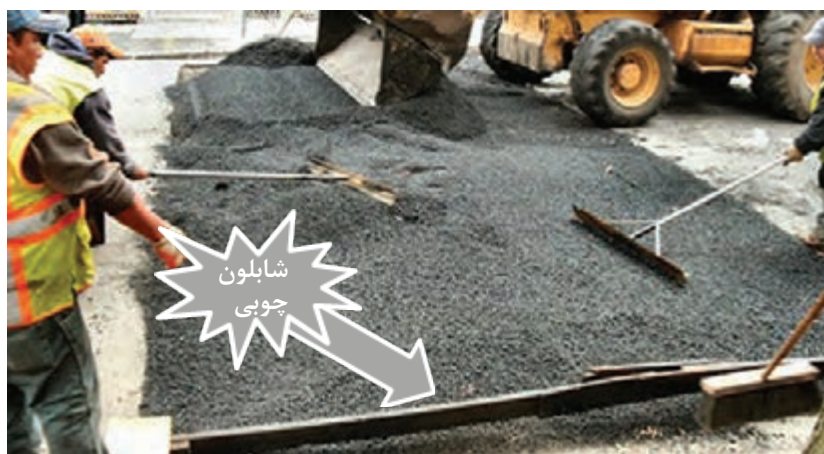
شکل ۲۳- اجرای سرعت‌کاه آسفالتی
