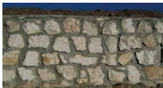
شکل ۱۷- استفاده از ملات در دیوارهای سنگی
