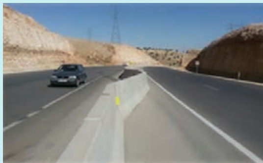
شکل ۵۵- وضعیت نیوجرسی بعد از تصادف با کامیون
