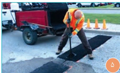
شکل ۷- مراحل اجرای سرعت گیر آسفالتی
