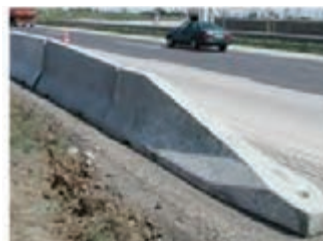
شکل ۷۵- شیب دار کردن انتهای حفاظ های بتنی
