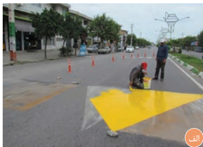
شکل ۲۷ - رنگ‌آمیزی سطح روسازی
