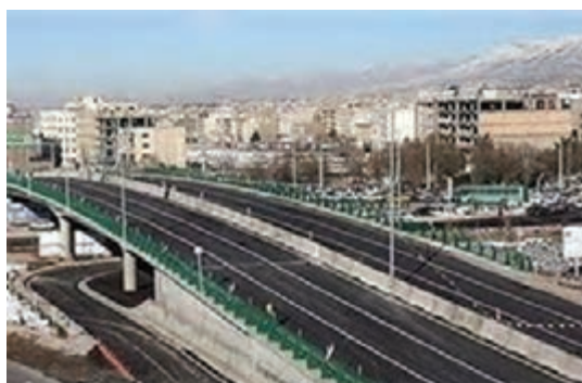
شکل ۲۴- ساخت و تولید نیوجرسی شکل ۲۵- استفاده از نیوجرسی بر روی پل بزرگراه شمالی همت در کرج
