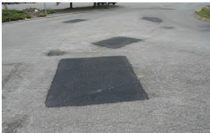
شکل ۹- نمونه ای از لکه گیری در روسازی آسفالتی
