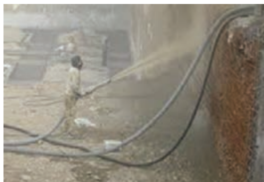
شکل ۲۰- اجرای بتن پاشی (شاتکریت) در بدنه سد
