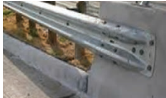
شکل ۸۱ - ناحیه انتقالی حفاظ دو موج به نیوجرسی
