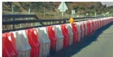
شکل ۲۹- حفاظ پلاستیکی نصب شده در مسیر
