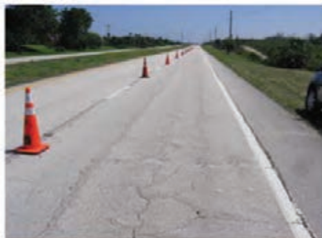
شکل ۳- ترک‌های بلوکی
