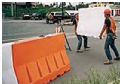
شکل ۳۰- حمل حفاظ پلاستیکی برای نصب در مسیر
