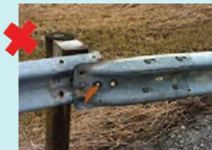
شکل ۱۵- نصب نامناسب گاردریل به دلیل عدم اتصال با پیچ و مهره
