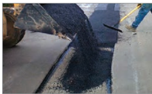
شکل ۴۰- روش ریختن و غلتک زدن
