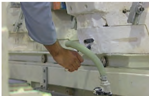
شکل ۴۰- باز کردن لوله‌ها جهت تخلیه دوغاب اضافی
