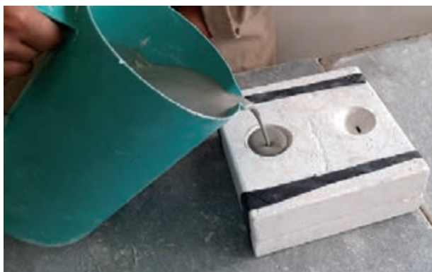
شکل ۳۴- ریختن دوغاب درون قالب
