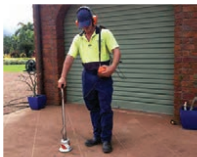
شکل ۹- تشخیص نشتی آب با دستگاه نشت یاب فراصوت ۱
