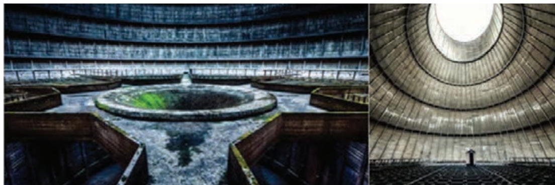
شکل ۲۰- خوردگی و رشد میکروارگانیسم‌ها در برج‌های خنک‌کننده
