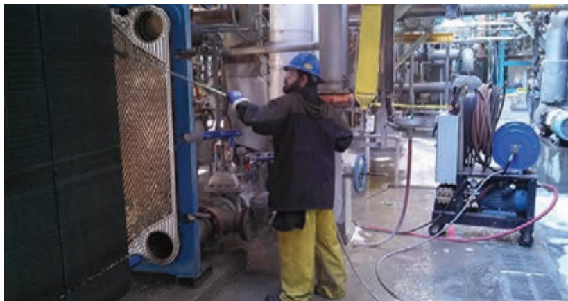
شکل ۱۴- روش فشار آب (جت آب)
