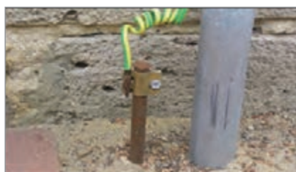
شکل ۴ - شیوه اتصال به چاه ارت
