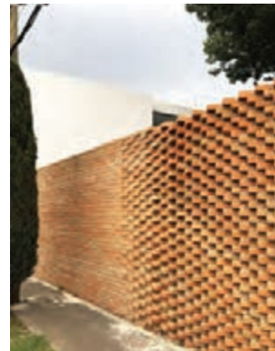
شکل ۴۱- آجرچینی هشت و گیر شکل ۴۲- آجرچینی دندان موشی شکل ۴۳- آجرچینی گل اندازی
