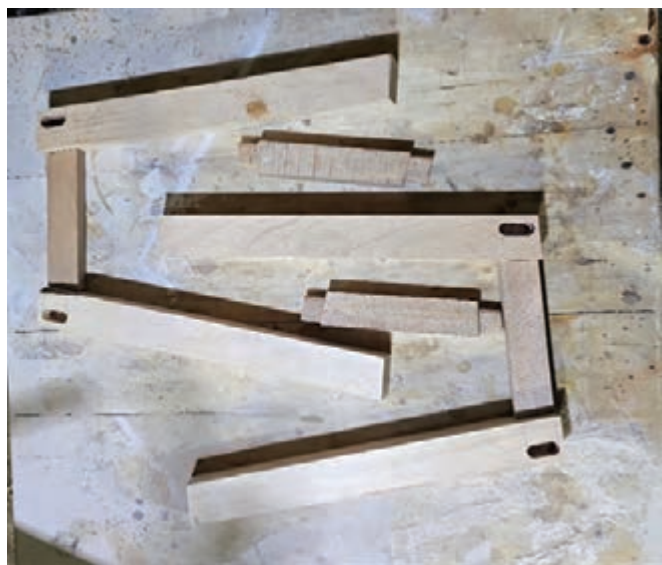
شکل ۱۷- اجرای کام بر روی پایه‌ها
