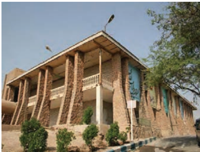
شکل ۳۰-۴. ساختمان گلف در اهواز
