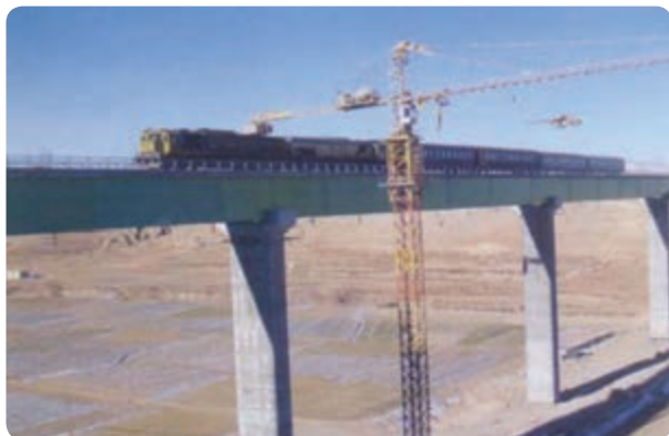
شکل ۴۱-۶ پل ایزده خواست
