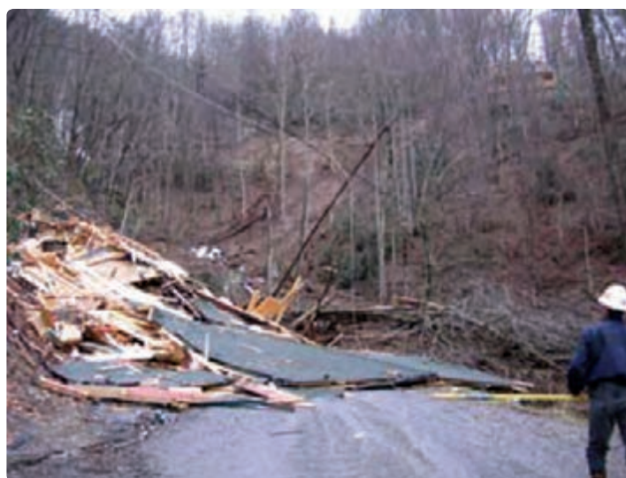
شکل ۱۲-۱- تخریب ناشی از رانش زمین
