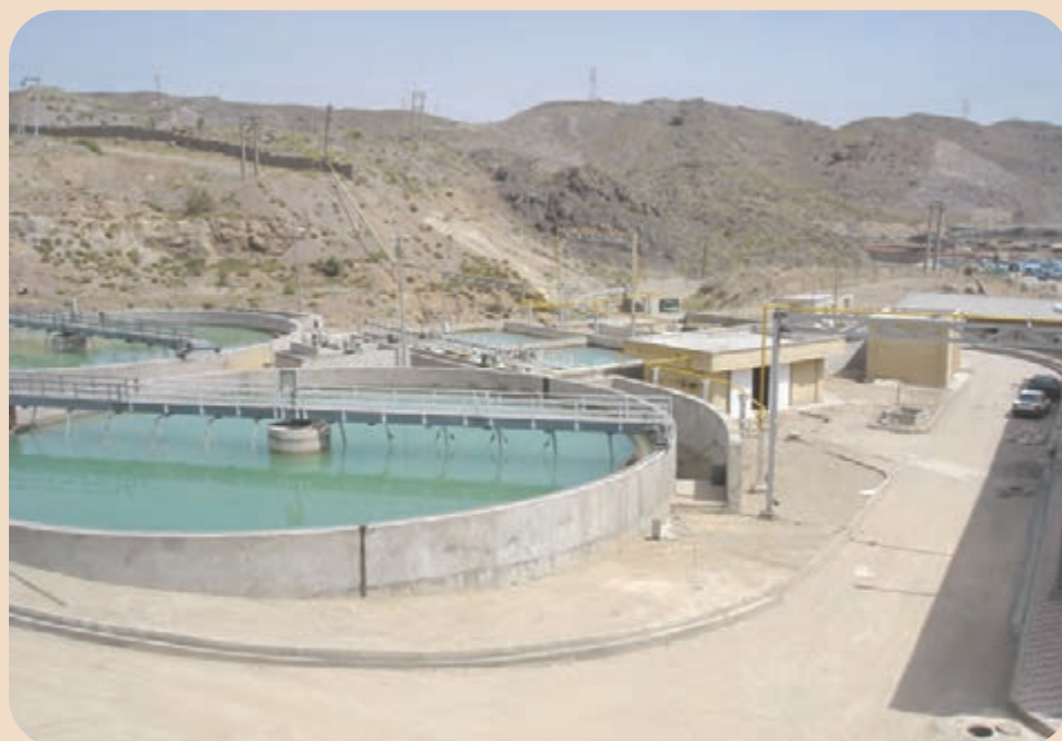
شکل ۱-۶۰- تصفیه خانه مجتمع مس سرچشمه
