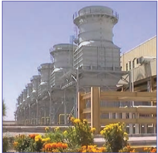
شکل ۶-۵- نیروگاه سیکل ترکیبی کرمان
