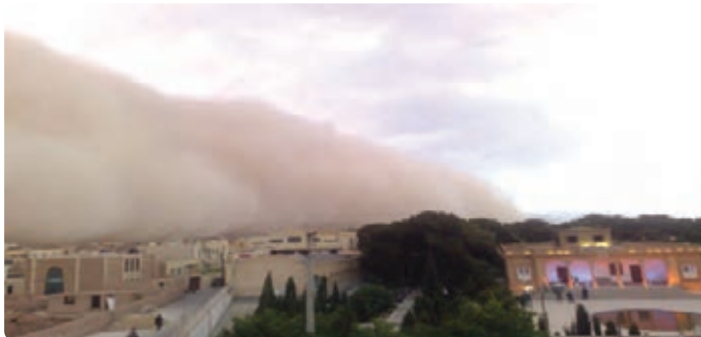
شکل ۴۷-۱- نمایی از طوفان‌های یزد در ساختمان آتشکده
