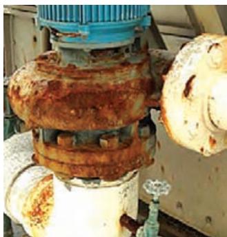
شکل ۵-۵۰- خوردگی الکتروشیمیایی قطعات فلزی
