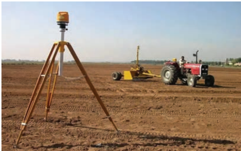
اجرای عملیات تسطیح لیزری
