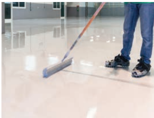
شکل ۱۱۸- استفاده از کفش یا دمپایی مخصوص میخ‌دار و غلتک مناسب در اجرای لایه اپوکسی
