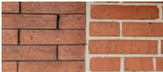
شکل ۹۱- مقایسه یک دیوار بندکشی‌شده با دیوار بدون بندکشی
