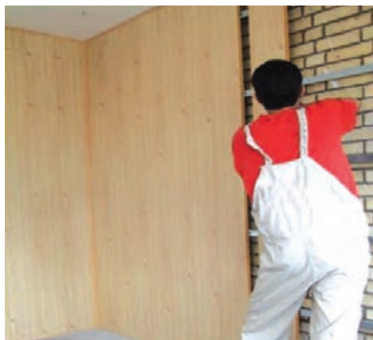
شکل ۲۲- حرکت پانل‌ها به صورت کشویی روی زیرسازی
