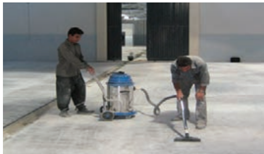
شکل ۹۷- زدودن گرد و غبار کف با استفاده از جاروبرقی صنعتی
