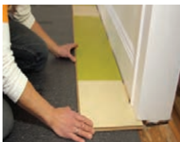
شکل ۵۶- ردیف اول تایل ها کنار دیوار قرار داده می شود.
