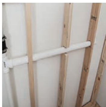
شکل ۲۷- عبور لوله‌های تأسیساتی در مرحله زیرسازی
