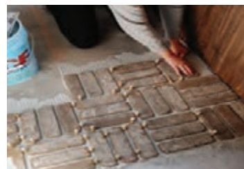
شکل ۱۴۳- فاصله نگهدار بین آجرها
