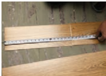
شکل ۳۵- تعیین محل برش قطعات پی‌وی‌سی
