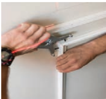
شکل ۱۴۴- قراردادن قطعات عمودی و افقی و ثابت کردن گوشه
