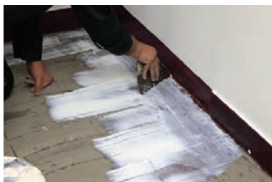
شکل ۳۱- استفاده از کاردک مخصوص برای پخش کردن چسب روی کف
