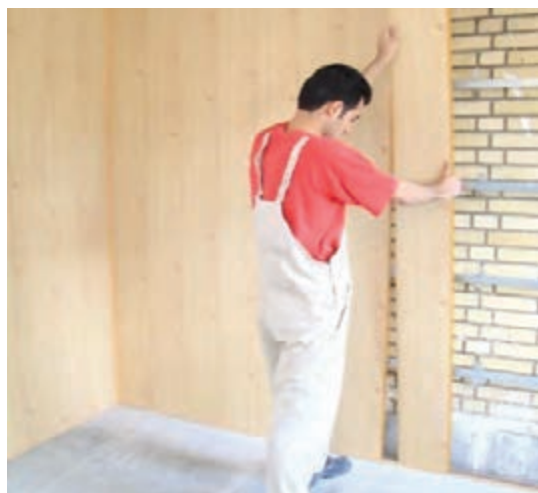
شکل ۲۱- نصب پانل‌ها روی زیرسازی فلزی
