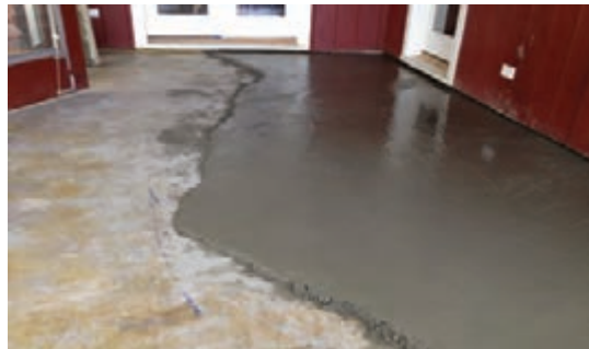
شکل ۱۳۸- تسطیح کف با ملات ماسه سیمان
