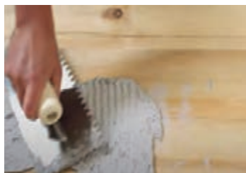
شکل ۱۴۴- پخش چسب با ماله دندانه دار
