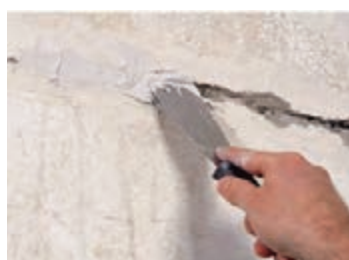
شکل ۱۰۹- پر کردن درزها با بتونه
