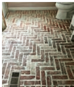
شکل ۱۵۵- بندکشی، نصب سرویس توالت فرنگی و دریچه تأسیساتی روی کف
