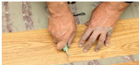
شکل ۳۶- برش قطعه پی‌وی‌سی با استفاده از کاتر
