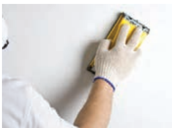
شکل ۱۱۰- سنباده زدن سطح دیوار
