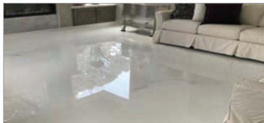
شکل ۷۹- کف پوش اپوکسی در فضای داخلی
