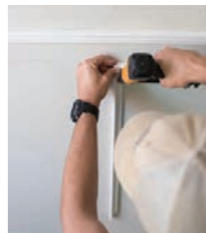
شکل ۱۴۶- محکم کردن گوشه با میخ کوب
