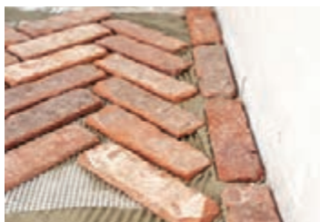
شکل ۱۴۵- نصب آجر بر روی چسب و شبکه مش پلاستیکی
