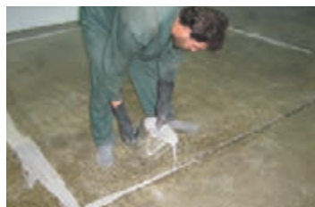
شکل ۱۰۱- ریختن اپوکسی بر روی محل درزها پس از قرار دادن توری پلیمری
