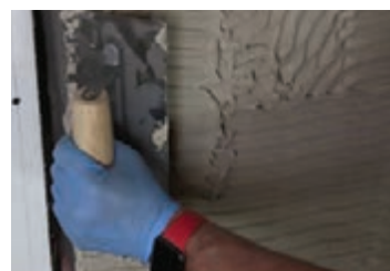
شکل ۸۸- پخش چسب با ماله شیاردار
