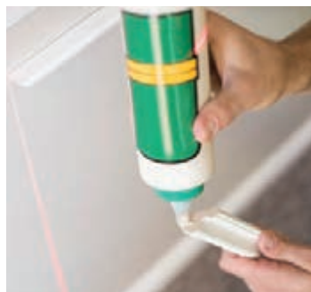
شکل ۱۴۳- چسب زدن قطعه عمودی
