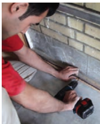
شکل ۱۵- اتصال رابط به پروفیل‌های افقی
