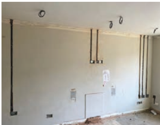
شکل ۷- بررسی وضعیت تأسیسات روی دیوار قبل از اجرا
