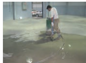
شکل ۹۴- ریختن ملات ماسه سیمان و پخش کردن آن برای پر کردن ترک‌ها و درزهای کف
