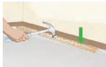
شکل ۶۷- بالشتک‌های میخی اتصال‌دهنده موکت به کف در گوشه‌ها
