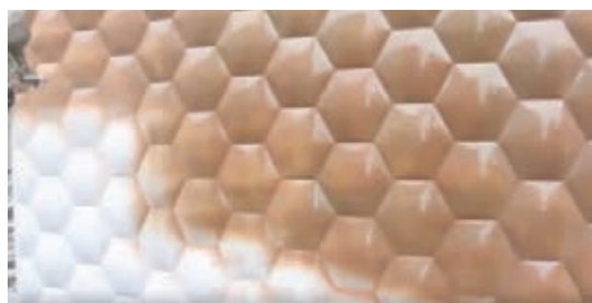
شکل ۴۴- رنگ آمیزی دیوارپوش پی‌وی‌سی با پیستوله
