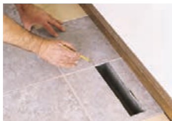
شکل ۱۳۳- دریچه بازدید در کف
