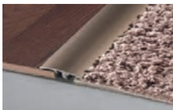
شکل ۷۵- ابزارهای فلزی تثبیت لبه‌ها در کف‌های ترکیبی
