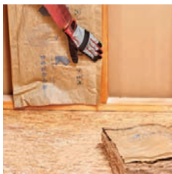
شکل ۲۶- نصب عایق حرارتی در زیر پانل‌ها
