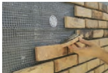
شکل ۸۷- نصب تور پلاستیکی زیر کار
