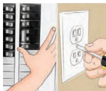
شکل ۱۱۷- باز کردن کلید و پریزها پس از قطع کردن برق
