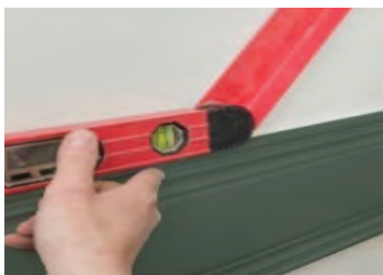
شکل ۱۶۰- کنترل تراز بودن قطعه نصب شده.
