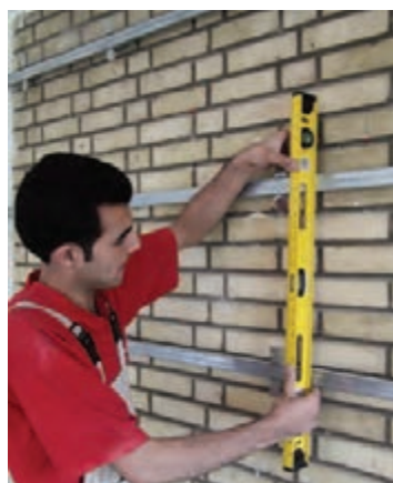
شکل ۱۶- کنترل فاصله و تراز بین رابط‌ها
