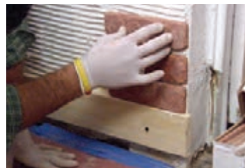
شکل ۸۵- تراز پای دیوار
