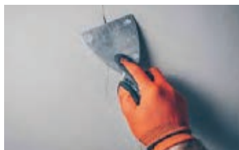
شکل ۸۳- پر کردن درزها با بتونه
