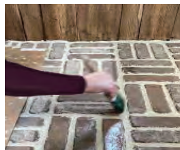
شکل ۱۴۹- مرحله رزین زدن روی سطح آجرها
