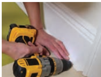
شکل ۶۴- قطعات قرنیز پس از اتصال با چسب، با میخ به دیوار کاملاً محکم می‌شود. لازم است قبل از میخ با استفاده از دریل حفرة‌ای در قرنیز ایجاد شود.
