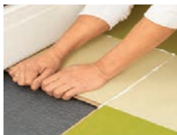
شکل ۶۲- در ردیف آخر ممکن است تایل‌ها برای اندازه‌شدن نیاز به برش داشته باشند. این کار با اندازه‌گیری دقیق انجام می‌شود. برای اتصال بهتر قطعات در محل قفل شدن آنها از چسب استفاده می‌شود.
