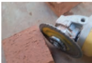
شکل ۱۴۲- برش آجر با دستگاه فرز
