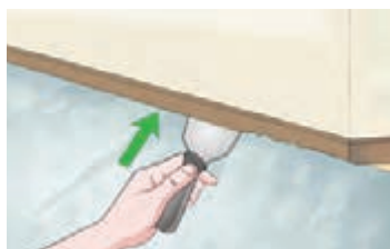
شکل ۷۳- لبه‌های فرش را با کاردک زیر قرنیز فشار دهید.
