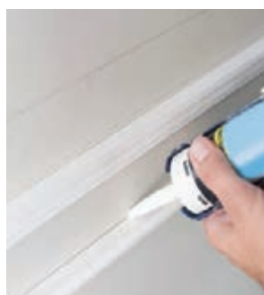
شکل ۱۵۲- چسب زدن لبه های کار
