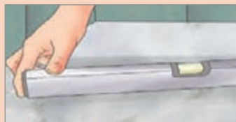
۵- با استفاده از تراز از مسطح و صاف بودن سطح فضا اطمینان حاصل کنید
