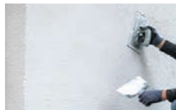
شکل ۸۲- گچ کاری
