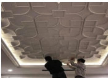
شکل ۱۶۹- سقف اجرا شده با طرح هندسی
