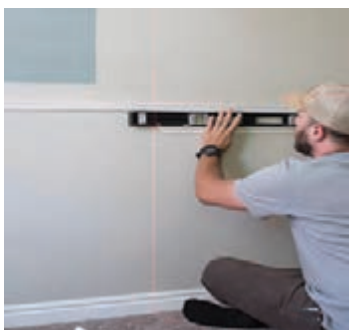
شکل ۱۴۱- نصب قطعه افقی و کنترل تراز بودن آن
