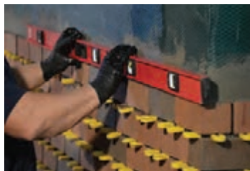
شکل ۸۶- کنترل تراز بودن رج‌ها
