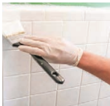
شکل ۱۰۸- اجرای پرایمر روی سطح کاشی
