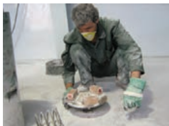
شکل ۹۵- ساب زدن با ساب دستی
