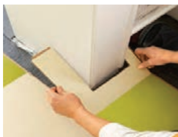
شکل ۶۱- قطعه کنار در، سر جای خود قرار داده می‌شود.
