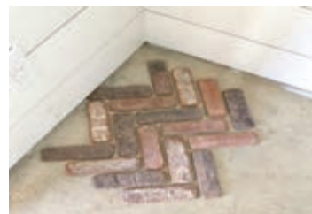
شکل ۱۴۰- چیدن آجر با طرح جناقی بدون ملات قبل از اجرای طرح
