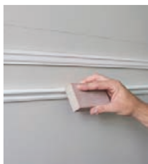
شکل ۱۵۳- کشیدن سنباده روی سطح بخش هایی از قاب که خمیر درزگیری استفاده شده است.
