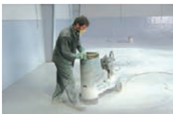
شکل ۱۰۸- ساب زدن کف
