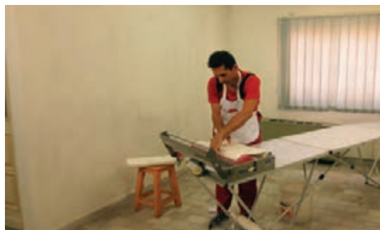
شکل ۱۲۵- قرار گیری رول کاغذ دیواری در دستگاه
