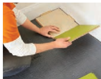
شکل ۵۴- شروع کار از گوشه انجام شده و قطعات به صورت کام و زبانه در هم قفل می شوند.
