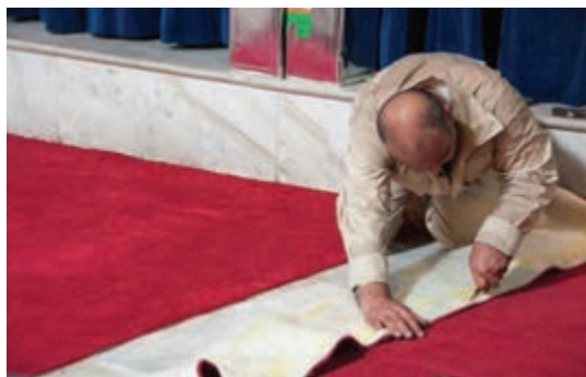
شکل ۷۸- برش زدن بخش‌های اضافی
