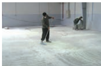
شکل ۱۰۹- جمع‌آوری گرد و غبار ناشی از ساب زدن
