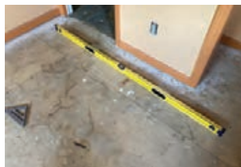
شکل ۱۳۴- کنترل تراز کف
