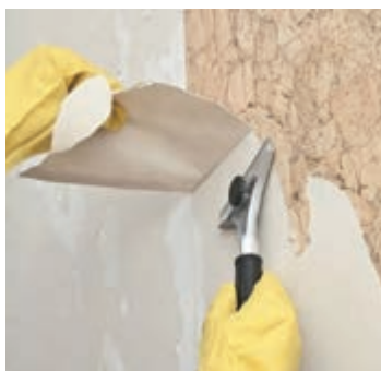
شکل ۱۰۷- برداشتن کاغذ دیواری از روی سطح دیوار
