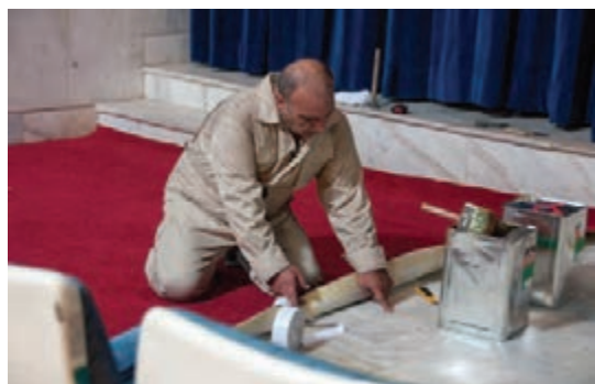
شکل ۶۶- استفاده از چسب دو طرفه برای اتصال لبه‌های موکت به کف
