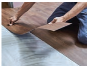
شکل ۹- قطعات کفپوش پی‌وی‌سی دارای کام و زبانه برای نصب شکل ۱۰- نصب کفپوش پی‌وی‌سی با چسب خمیری شکل ۱۱- کفپوش پی‌وی‌سی دارای برچسب
