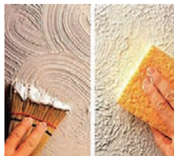
شکل ۱۱۲- استفاده از ابزار برای ایجاد بافت (بدون رنگ)
