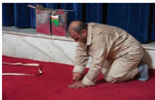
شکل ۸۱- کنترل لبه‌ها و برش بخش‌های اضافی
