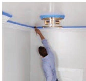
شکل ۱۴۷- نصب چسب نواری در روی ابزارهای سقف و دور لوستر
