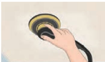
شکل ۱۷۶- برای اتصال بهتر قطعه به سقف با استفاده از سنباده. سطح بخشی از سقف را که ابزار نصب می‌شود مضرس می‌کنند.
