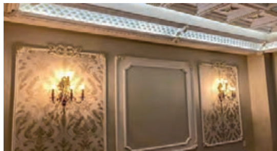
شکل ۱۲۷- استفاده از قاب‌بندی طرح دار که داخل آن با کاغذ دیواری پوشانده و چراغ‌های دیواری روی آن نصب شده‌اند.
