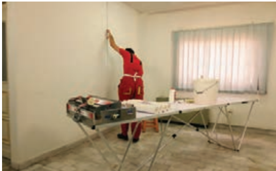
شکل ۱۱۴- اندازه‌گیری ارتفاع دیوار
