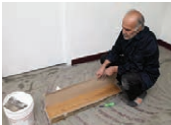
شکل ۳۴- خارج کردن قطعات پی‌وی‌سی
