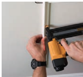
شکل ۱۴۵- ثابت کردن قطعه عمودی با میخ کوب
