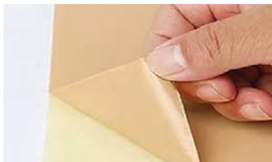
شکل ۵۲- برداشتن کاغذ پشت دیوارپوش
