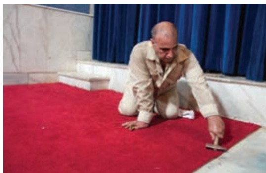
شکل ۶۵- کشیدن ممتد چکش لاستیکی روی تمام بخش‌های لبه برای کسب اطمینان از چسبیدن لبه‌ها
