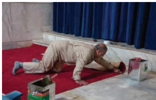
شکل ۶۴- کشیدن چکش لاستیکی بر روی محلی که چسب زده شده است.
