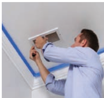
شکل ۱۴۸- باز کردن دریچه هواکش
