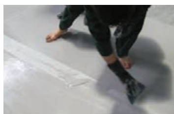
شکل ۱۰۶- کنترل اپوکسی درزها و هم‌سطح کردن اپوکسی آن با بخش‌های کناری
