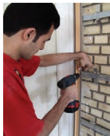
شکل ۱۴- اتصال رابط به پروفیل‌های عمودی
