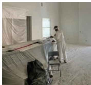
شکل ۱۴۹- پوشاندن کف کارگاه و وسایل موجود در آن
