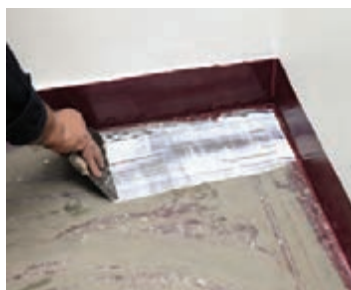
شکل ۲۹- پهن کردن چسب با استفاده از کاردک
