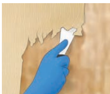
شکل ۱۱۸- جدا کردن کاغذ با پوشش قبلی از سطح دیوار
