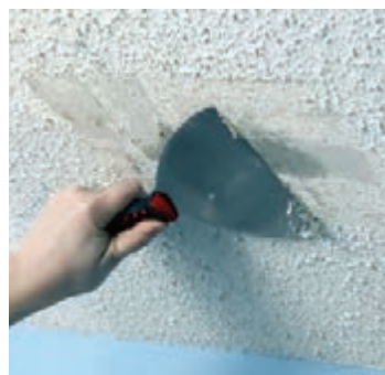
شکل ۱۰۶- برداشتن کنیتکس از روی سطح دیوار
