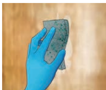
شکل ۱۱۹- تمیز کردن سطح دیوار از آلودگی‌ها
