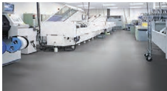
شکل ۸۵- اجرای کف پوش اپوکسی آنتی استاتیک در کارخانه های تولید وسایل و قطعات الکترونیکی
