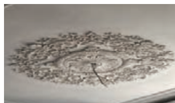
شکل ۱۸۵- ابزار اجرا شده بر روی سقف
