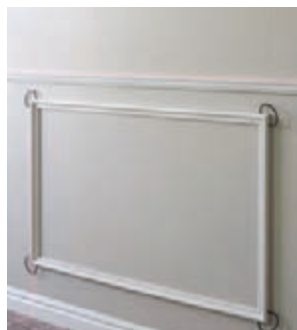
شکل ۱۴۹- ثابت نگه داشتن چهار طرف قاب
