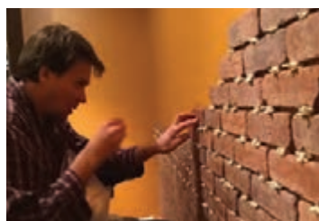
شکل ۹۰- اجرای فاصله‌نگهدار بین آجرها
