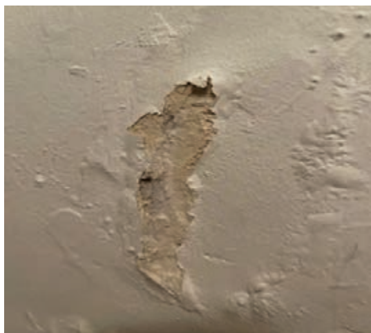
شکل ۱۰۱- رطوبت روی سطح دیوار
