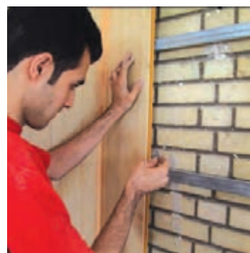
شکل ۲۵- نصب قطعات اتصال پانل و زیرسازی
