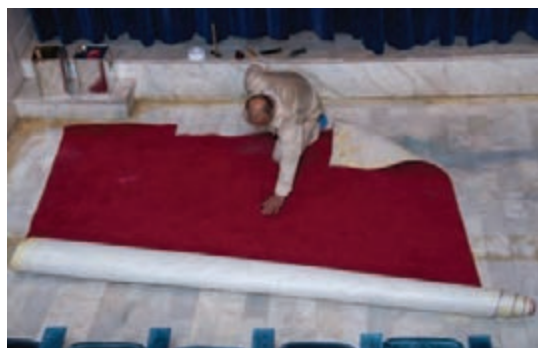
شکل ۶۱- پهن کردن موکت بر روی کف فضا
