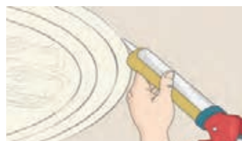
شکل ۱۸۴- درزبندی اطراف کار با خمیر درزگیری که رنگ آن نزدیک به رنگ نهایی است انجام می‌گیرد.
