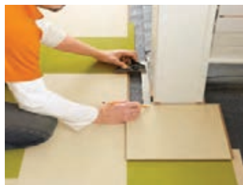
شکل ۵۹- فاصله ایجاد شده کنار چارچوب اندازه‌گیری می‌شود.
