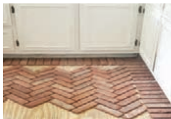
شکل ۱۴۱- چیدن آجر با طرح حاشیه در کناره‌ها و جناقی در وسط (بدون ملات قبل از اجرای طرح)
