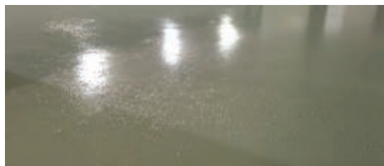
شکل ۹۱- ایجاد حباب بر روی سطح کف‌پوش به دلیل رطوبت در بستر زیرین
