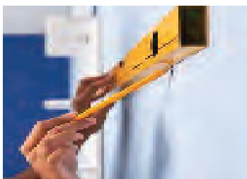
شکل ۱۵۷- تعیین محل نصب و علامت‌گذاری محل نصب
