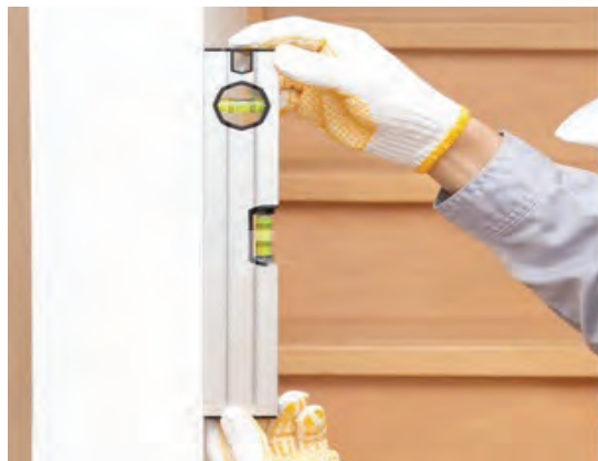
شکل ۸- بررسی وضعیت شاقولی دیوار
