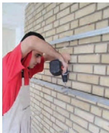
شکل ۱۳- نصب قطعات رابط اتصال پروفیل‌ها به دیوار
