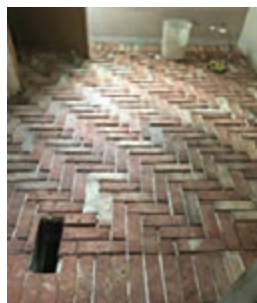
شکل ۱۵۴- پایان یافتن نصب آجرهای کف
