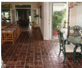
شکل ۱۵۱- کف پوش آجری پس از اجرای رزین (آشپزخانه)
