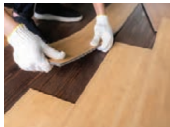
شکل ۹- قطعات کفپوش پی‌وی‌سی دارای کام و زبانه برای نصب شکل ۱۰- نصب کفپوش پی‌وی‌سی با چسب خمیری شکل ۱۱- کفپوش پی‌وی‌سی دارای برچسب
