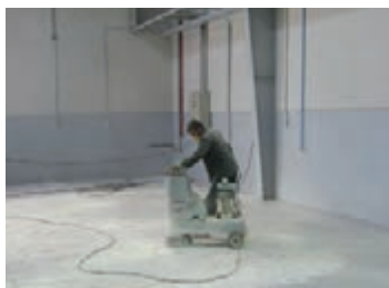
شکل ۹۶- استفاده از دستگاه ساب‌زنی برای سطوح بزرگ
