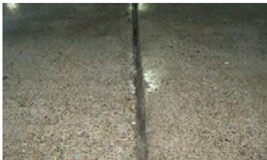
شکل ۱۰۰- نمایی نزدیک از سطحی که پرایمر روی آن اجرا شده است.
