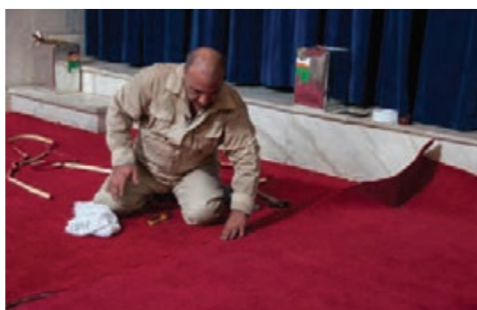
شکل ۸۰- کنار هم قرار دادن لبه‌ها
