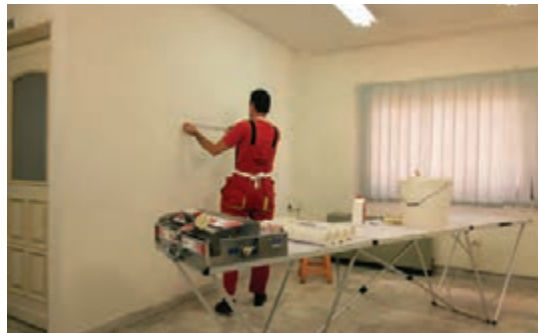
شکل ۱۱۳- اندازه‌گیری عرض دیوار
