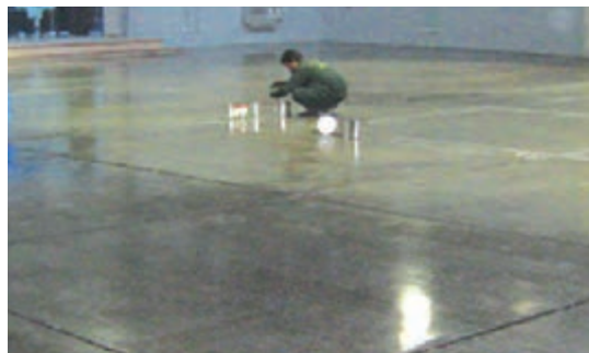
شکل ۹۹- اجرای پرایمر روی کف
