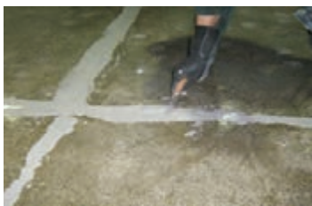
شکل ۱۰۲- هموار کردن سطح اپوکسی محل درزها
