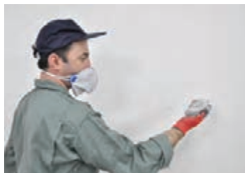
شکل ۳۸- نحوه نگهداری سنباده روی انگشتان دست
