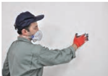
شکل ۳۹- نحوه سنباده زنی روی دیوار
