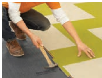
شکل ۵۸- برای اتصال محکم قطعات و قرارگیری تمام تایل‌ها در یک راستا با استفاده از چکش به قطعات ضرباتی افقی وارد می‌شود.
