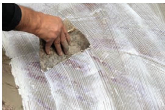
شکل ۳۲- چسب کاری سطحی به مساحت حدود ۲ مترمربع
