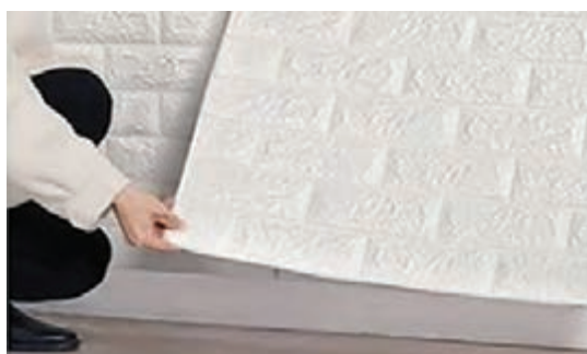
شکل ۵۳- نصب قطعات دیوارپوش
