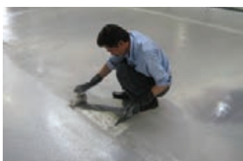
شکل ۱۰۵- تسطیح کردن سطح
