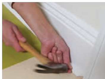
شکل ۶۵- استفاده از میخ برای اتصال محکم‌تر قرنیز به دیوار انجام می‌شود.
