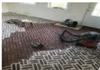
شکل ۱۴۷- پخش ملات روی سطح کف
