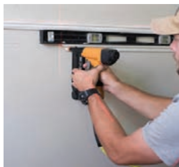
شکل ۱۴۲- اتصال قطعه به دیوار با استفاده از میخ کوب
