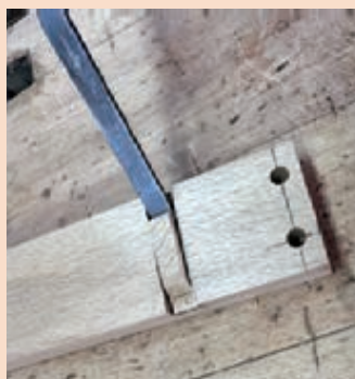
شکل ۲۲۱- نحوه مغار کاری در حالت خوابیده قطعه
