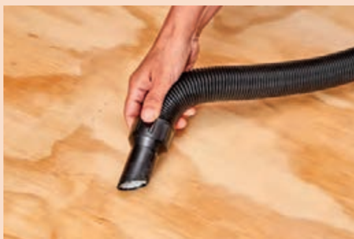
شکل ۱۱۷- پاک کردن سطح
