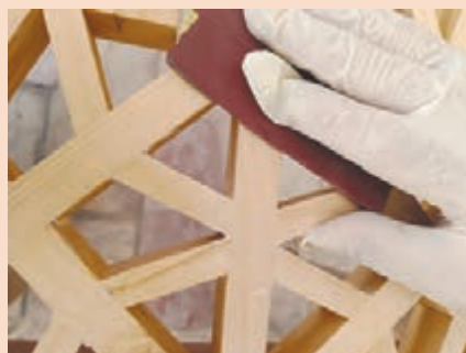
شکل ۱۳۵- سنباده زدن بتونه ها با دست
