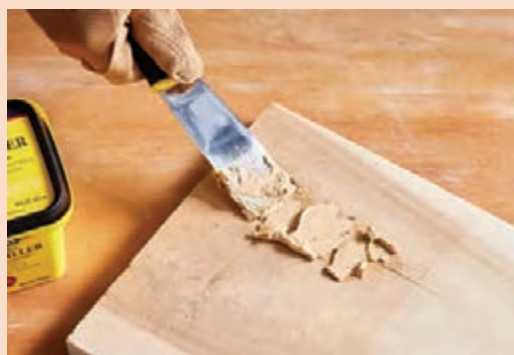
شکل ۱۰۷- پر کردن ترک با بتونه
