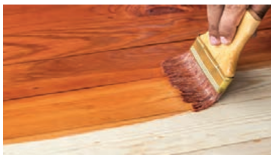
شکل ۶۱- آستری زدن با قلم‌مو
