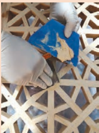
شکل ۱۳۴- بتونه کاری درزها
