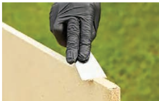
شکل ۵۹- بتونه کاری لبه با کاردک
