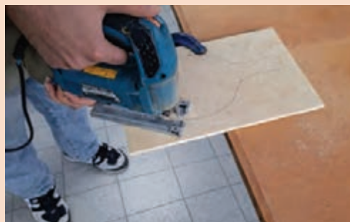
شکل ۸۹- برش الگو توسط اره عمودبر
