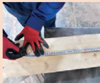
شکل ۱۸۴- اندازه گیری طول قطعه
