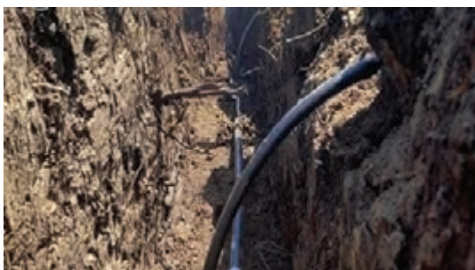
شکل ۴۲- آرایش زیرسطحی در آبیاری قطره‌ای
